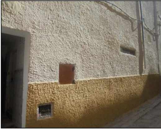
Figure 20,21.II : Revêtement des façades par l'enduit à chaux, prise par les étudiantes
