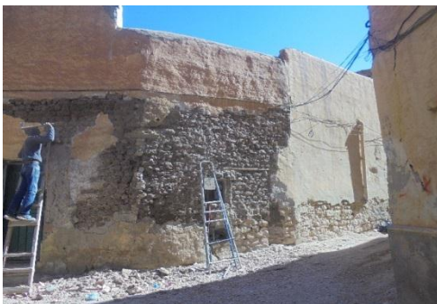
Figure 15,16 .II: le décapage des enduits extérieur au niveau des façades ; prise par les étudiantes
