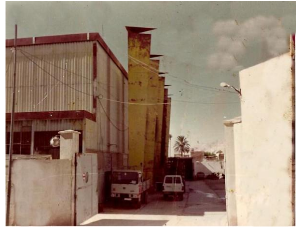
Figure 54.III : Central électrique de Laghouat [28]
