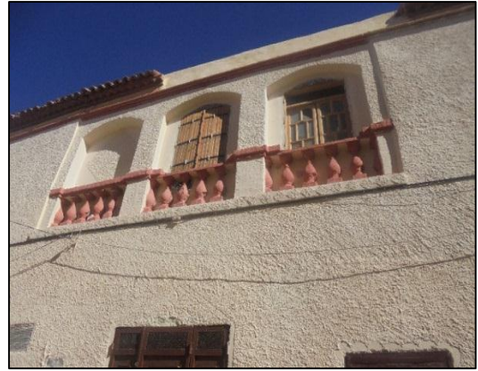
Figure 20,21.II : Revêtement des façades par l'enduit à chaux, prise par les étudiantes
