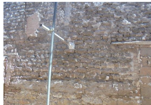
Figure 15,16 .II: le décapage des enduits extérieur au niveau des façades ; prise par les étudiantes
