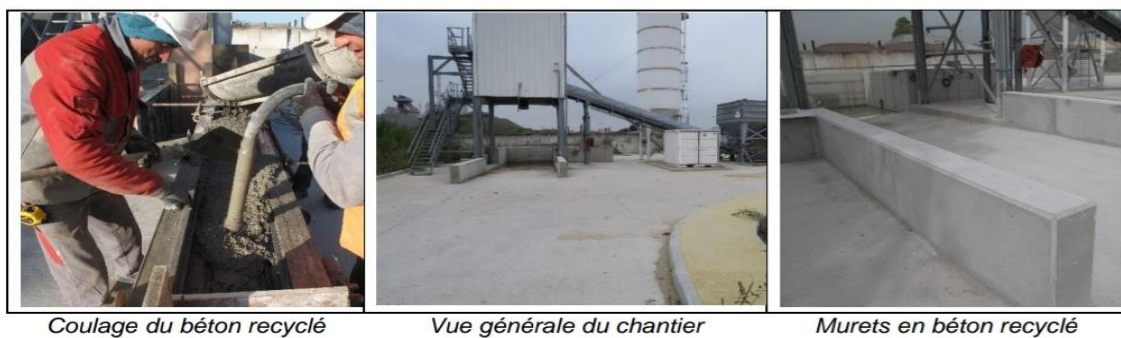
Figure I.22 : vues du chantier de Gennevilliers.
