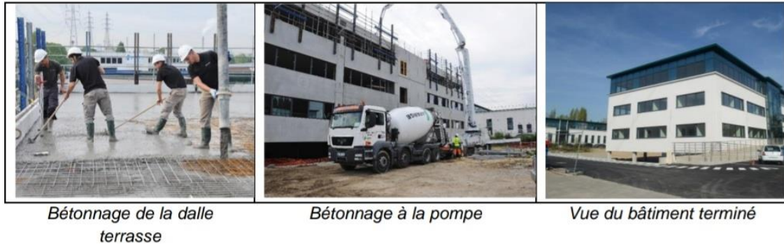
Figure I.21 : vues du chantier de Villeneuve-la-garenne.
