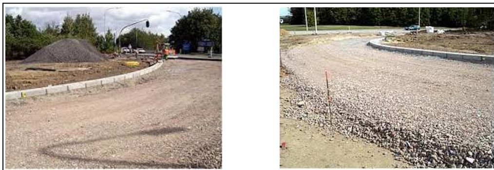
Figure I.23 : sous-fondation de voirie en GBR [49].
