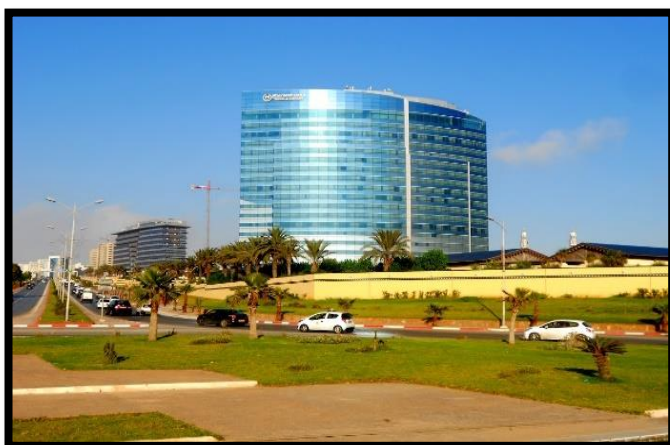
Figure n° 66 : hôtel Sheratonn de la ville D'Oran Source: prise par l'auteur
