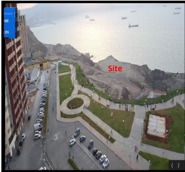
Figure n° 73 : vue sur le site d'intervention Source: prise par l'auteur
