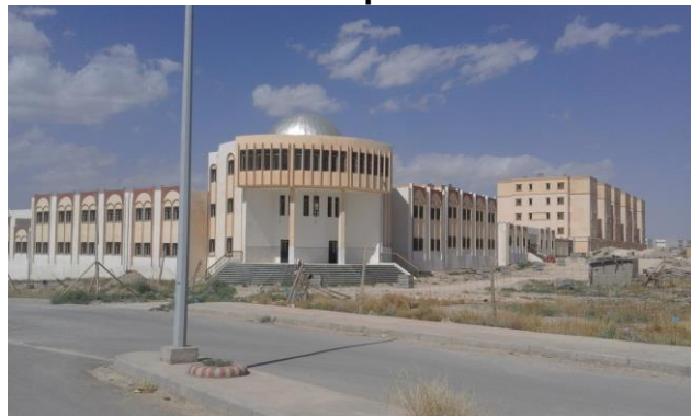
Figure 107 : L'entrée du C.F.P.A limite Nord.
