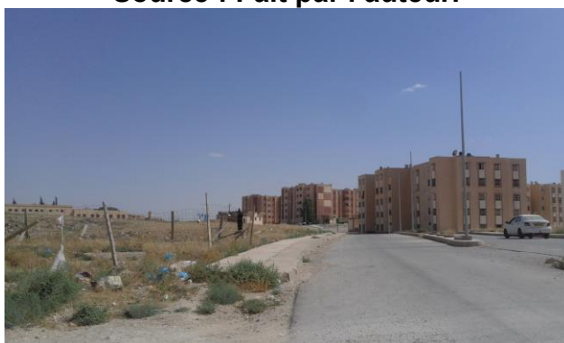
Figure 111 : bâtiments en R+4 limite Sud. Source : Fait par l'auteur.
