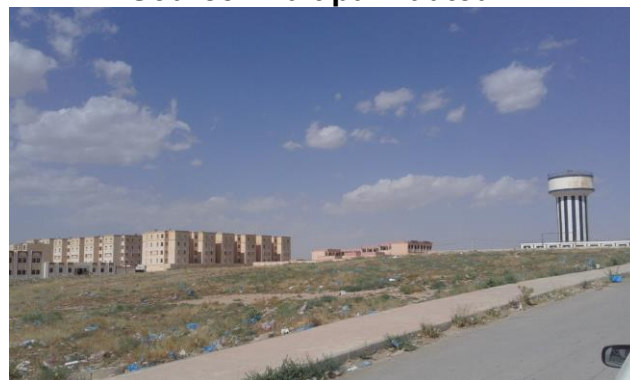
Figure 108 : L'assiette du terrain & le réservoir d'eau limite Est.
