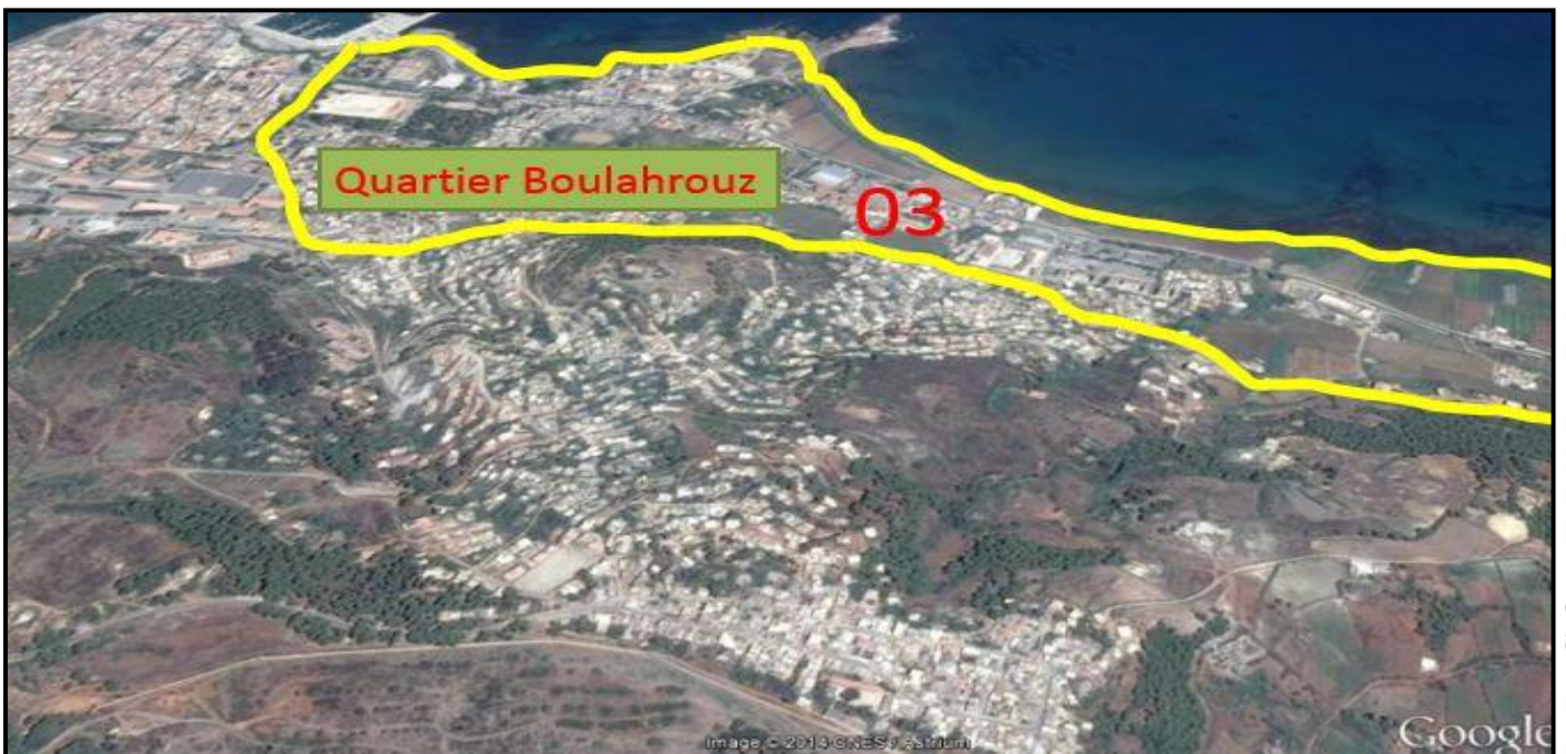
Photo aérienne 10 : Quartier Ain Boulahrouz / source : Google Earth / modifier par l'auteur
