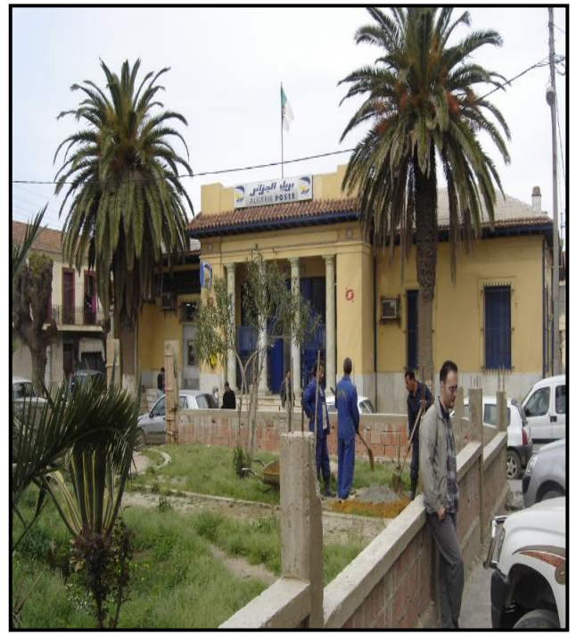
Photo 62 : la poste / source : l'auteur
