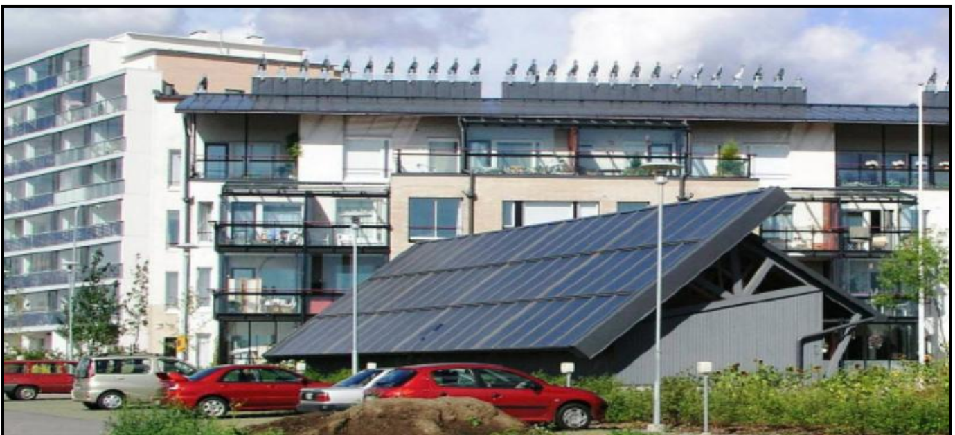
Photo N°43: panneaux photovoltaïques a eco-vikki / source : internet
