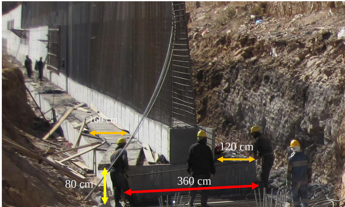
Figure III.11 : Vue sur la réalisation de première semelle
