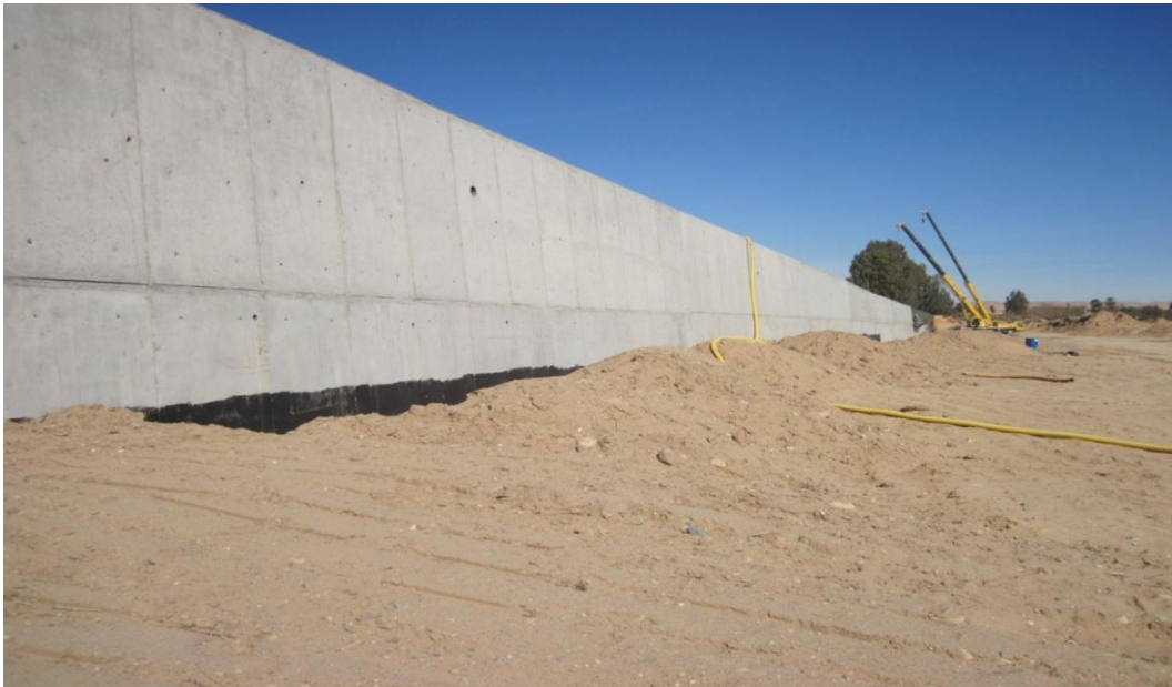
Figure I.2 : Vue globale sur la 1 ère partie de mur de soutènement au Khat l'Oued -Laghouat-
