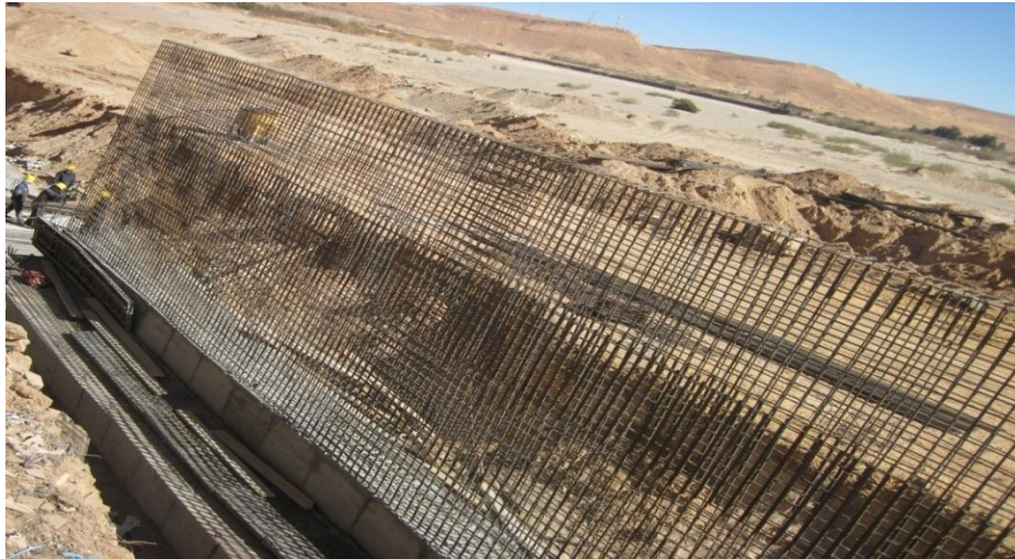
Figure III.9: Vue sur la réalisation d'une première voile
