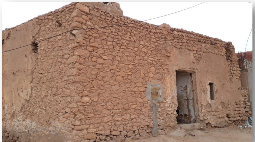
Figure 66 : Vue sur la Façade principale - source : Auteur
