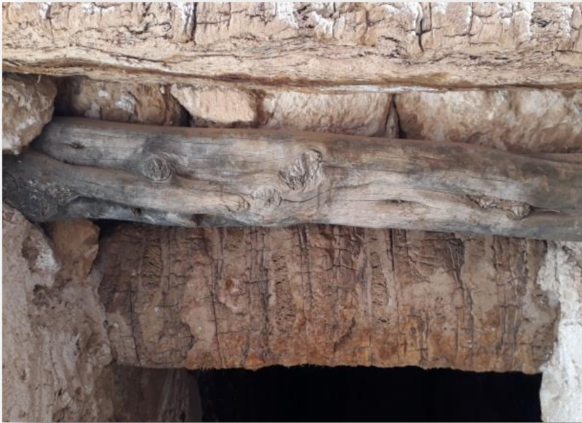
Figure 76 : Lindeaux en peuplier d'Italie et en tronc de palmier - source : Auteur
