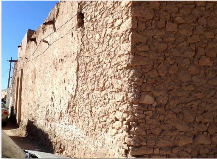
Figure 12 : Dégradation de la pierre – source : Auteur
