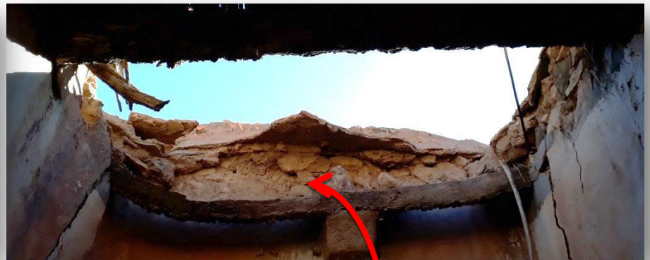
Figure 23 : Fléchissement des solives (chambre) - source : Auteur
