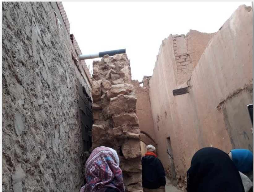
Figure 47 : Mur en pierre - Source : Auteur
