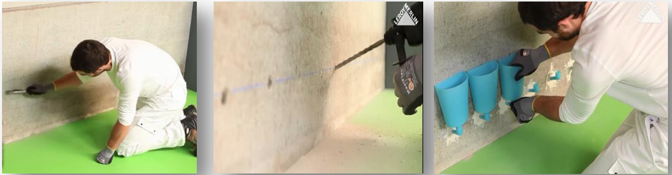
Figure 32 : Méthode d'injection – source : Atelier de Leroy Merlin
