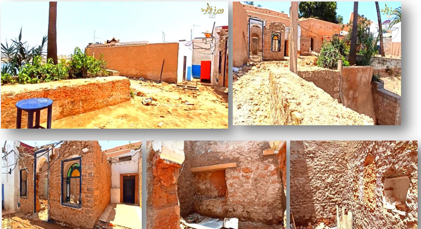
Figure 16 : Travaux de réhabilitation : e : les annexes sanitaires, f : la deuxième terrasse, g : les annexes sanitaires, h : l'ancienne cuisine - source : M. Merrad reportage دويرةفالحومة
