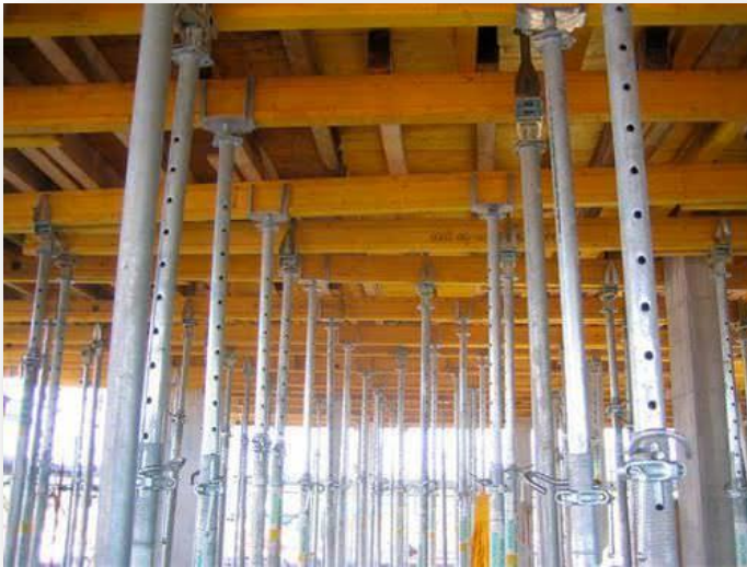
Figure 35 : Exemples d'étaieement du plancher - source : www.abc-maçonnerie.com
