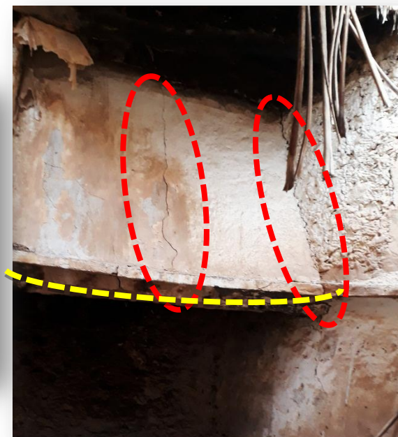
Figure 19 : Cheminée de la cuisine - source : Auteur
