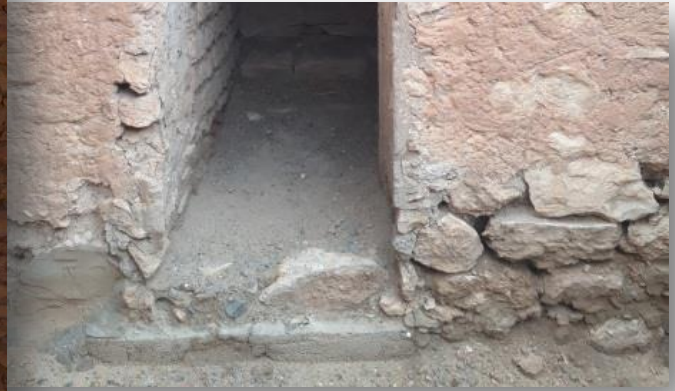
Figure 12 : Dégradation de la pierre – source : Auteur
