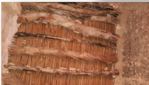
Figure 74 : Planchers de la chambre - source : Auteur
