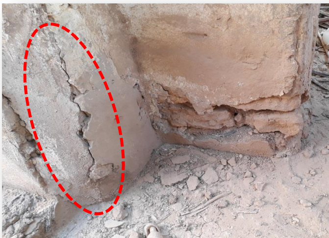
Figure 5 : Fissures montantes dues aux sollicitations des fondations, a : le mur de la cuisine, b : mur de la chambre – source : Auteur
