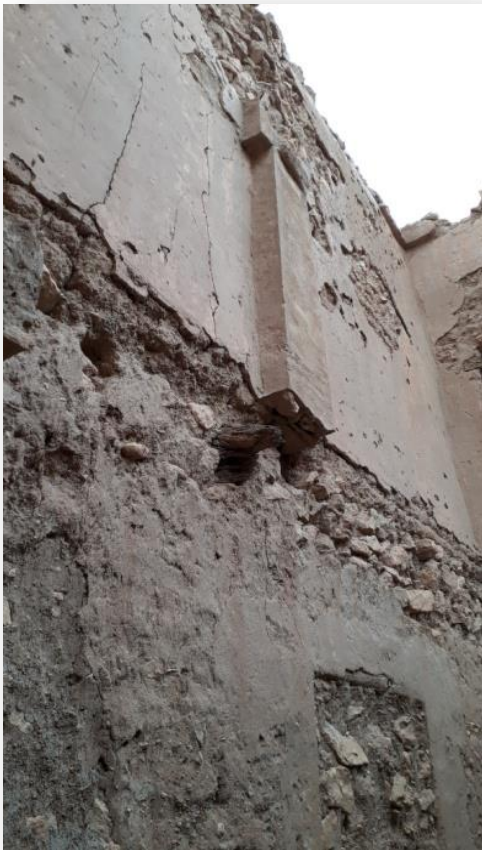
Figure 53 : L'effondrement du plafond et la dégradation de l'entrée Bâb el sghir et l'absence de la maintenance – source : Auteur
