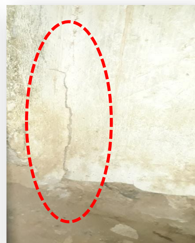
Figure 5 : Fissures montantes dues aux sollicitations des fondations, a : le mur de la cuisine, b : mur de la chambre – source : Auteur
