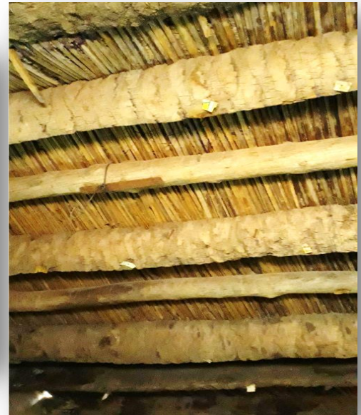
Figure 23 : Fléchissement des solives (chambre) - source : Auteur
