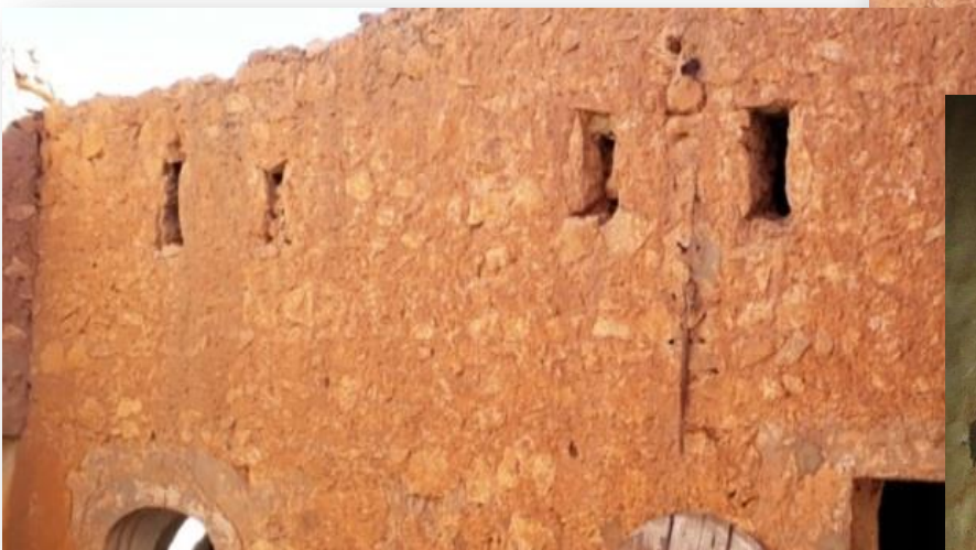
Figure 77 : Les niches d'aération - source : Auteur
