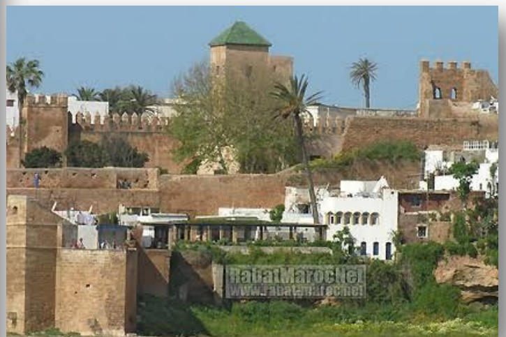
Figure 10 : Vue sur la terrasse du café de la Casbah - Source : www.alarmy.com
