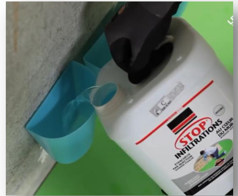
Figure 32 : Méthode d'injection – source : Atelier de Leroy Merlin
