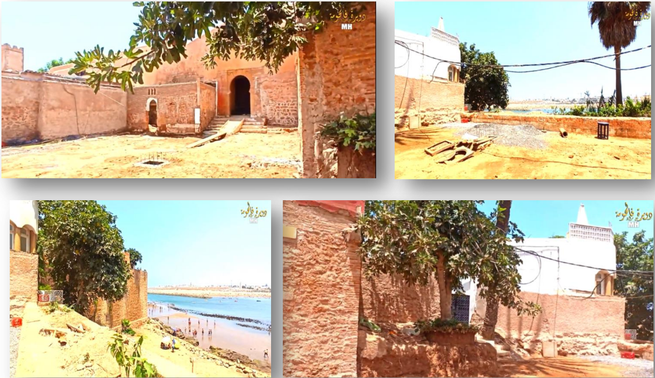
Figure 15 : Travaux de réhabilitation : a : Espace de préparation et l'entrée, b : la terrasse du café qui donne sur oued Regurag, c : le panorama Oued et remparts, d : Terrasse qui donne sur le palais - source : M. Merrad reportage دويرةفالحومة
