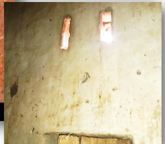
Figure 77 : Les niches d'aération - source : Auteur
