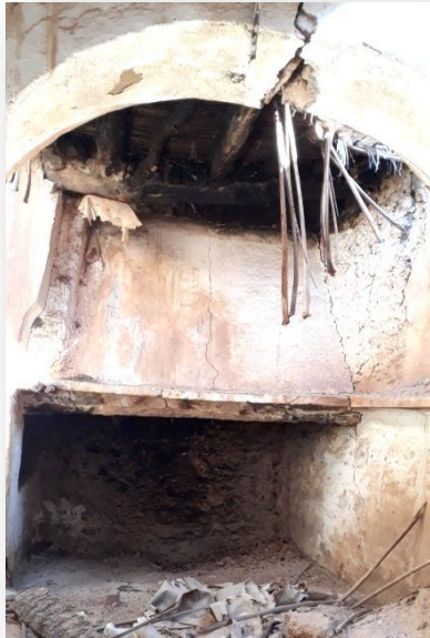
Figure 79 : Cheminée a- l'espace cuisant, b- la chambre - source : Auteur
