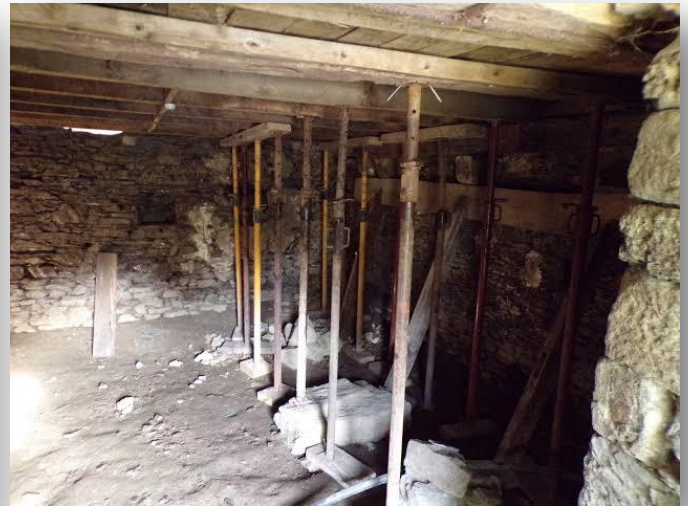
Figure 35 : Exemples d'étaieement du plancher - source : www.abc-maçonnerie.com
