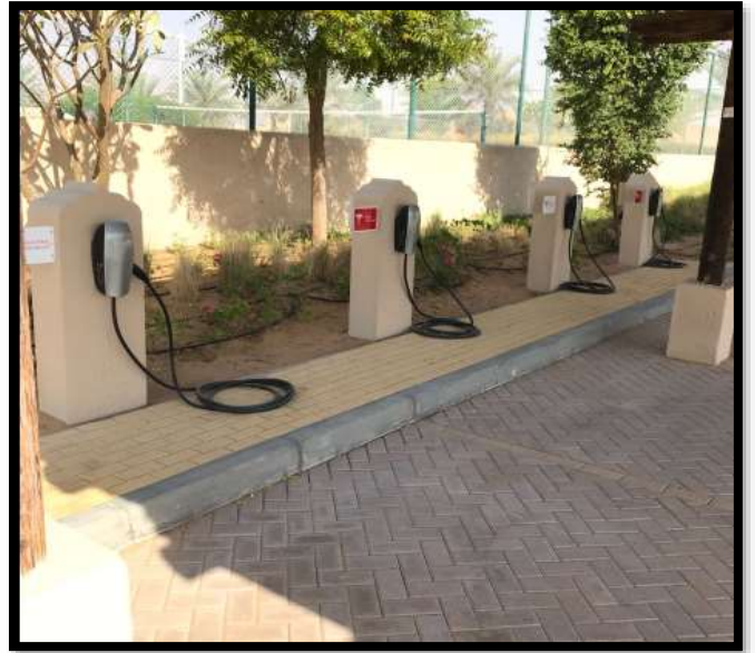
الصورة 49 : محطة شحن السيارات الكهربائية المصدر : https://www.emaratalyoum.com
