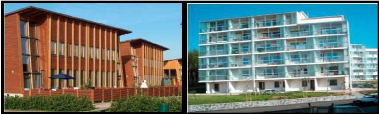
Figure I-15 : les grandes surfaces de vitrage dans les bâtiments, Source: www.helsinginenergia.fi/kaukolampo/ekoviikki.html
