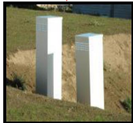
Figure I-46: la sortie de puit canadienne de la maison , Source : http://lab-immo.ch/1037/ - Minergie-P- ECO MAISON
