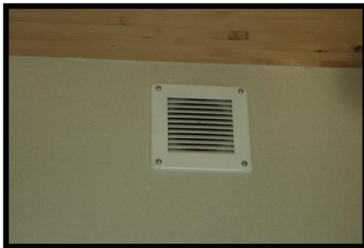
Figure I-49: photo représente les bouche d'extraction, Source : http://lab-immo.ch/1037/-/ Minergie-P-ECO
