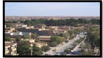
Figure II-07 : photo représente les lotissements de la ville de Djelfa, source : Archive des photos de la Direction d'Urbanisme et de Construction, Djelfa.
