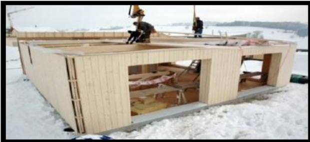
Figure I-26 : photos qui montre les travaux de réalisation, Source : http://lab-immo.ch/1037/- Minergie-P-ECO MAISON
