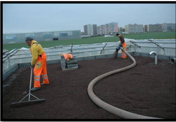
Figure I-31 : pompage du sable sur la dalle Source : http://lab-immo.ch/1037/ - Minergie-P-ECO MAISON
