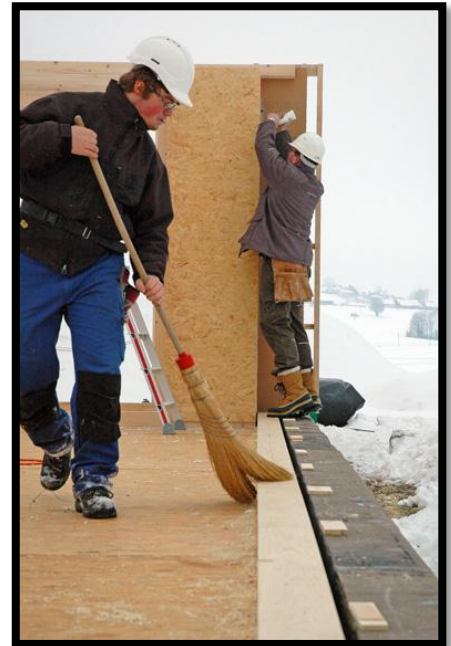
Figure I-44: la préparation des travaux de la maison http://lab-immo.ch/1037/ - Minergie-P-ECO MAISON
