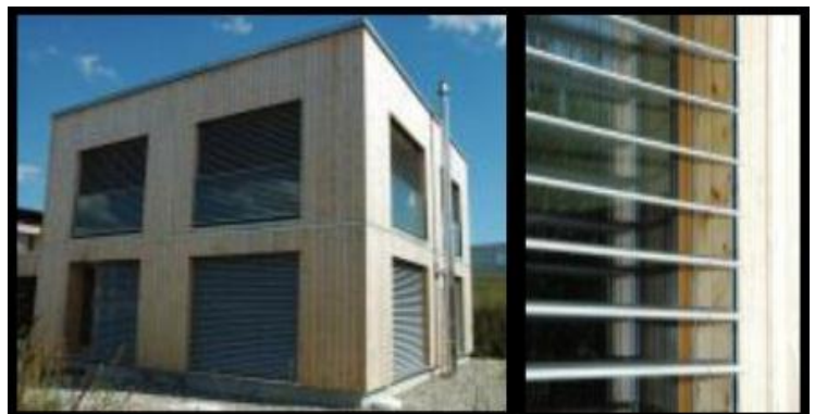
Figure I-41 : store électrique utilise dans la maison, Source : http://lab-immo.ch/1037/-
