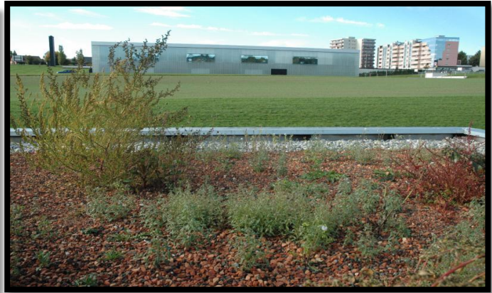
Figure I-32 : toiture végétalisée Source : http://lab-immo.ch/1037/ - Minergie-P-ECO MAISON
