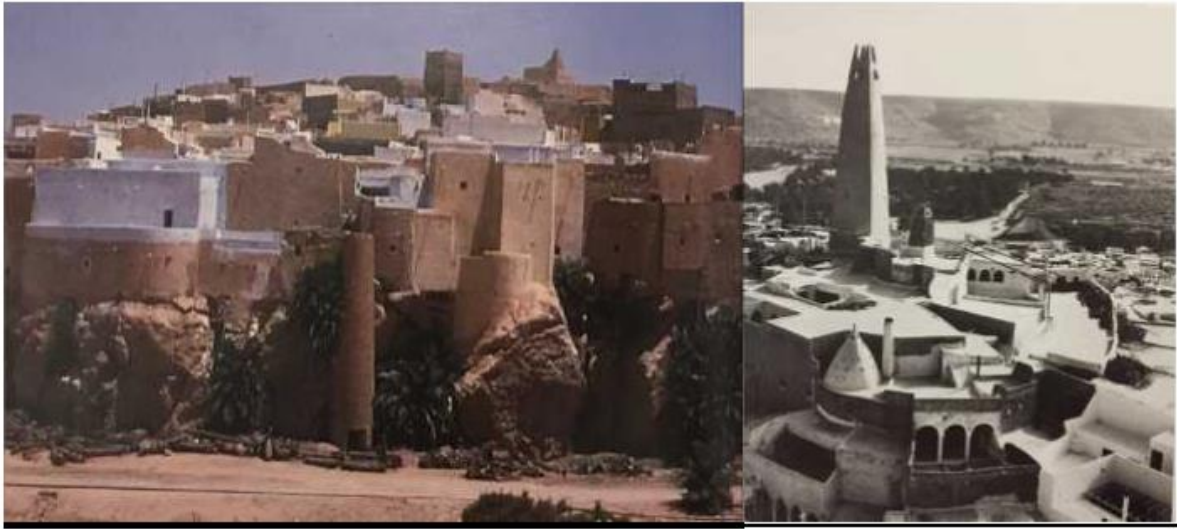
Figure 69 : vue démontrant la structure de la ville de Ghardaïa
