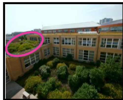
Photo31 : des terrasses végétalisées
