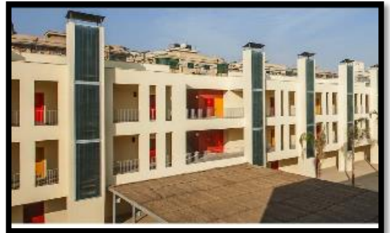
Photo 16 : les cheminées solaires
