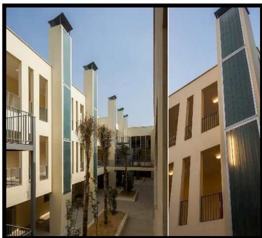
Photo 20 : Les cheminées solaires
