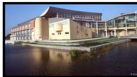
Photo27 : la récupération des eaux pluviales
