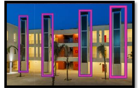
Photo 8 : Les cheminées solaires
