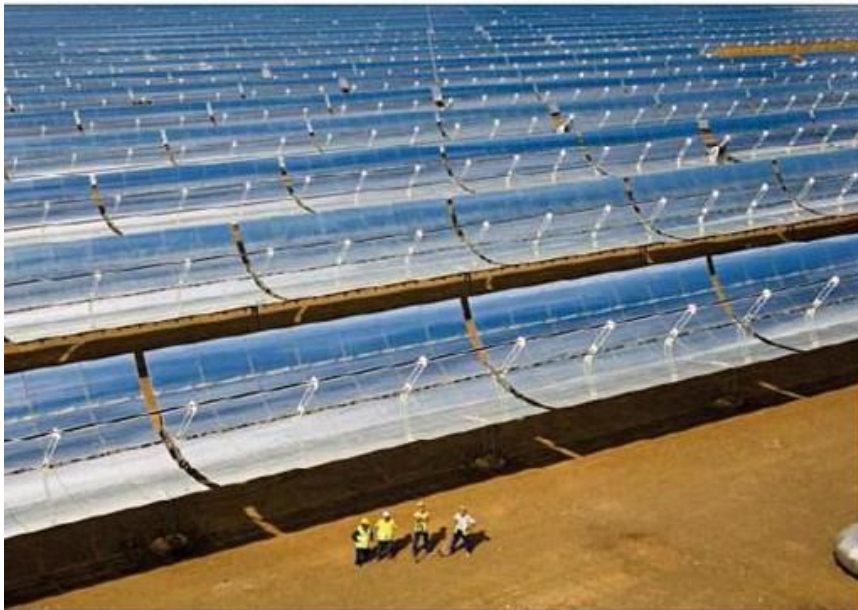
Figure III.3 Champ solaire des réflecteurs cylindro-paraboliques pour la centrale solaire thermique ANDASOL en ESPAGNE
