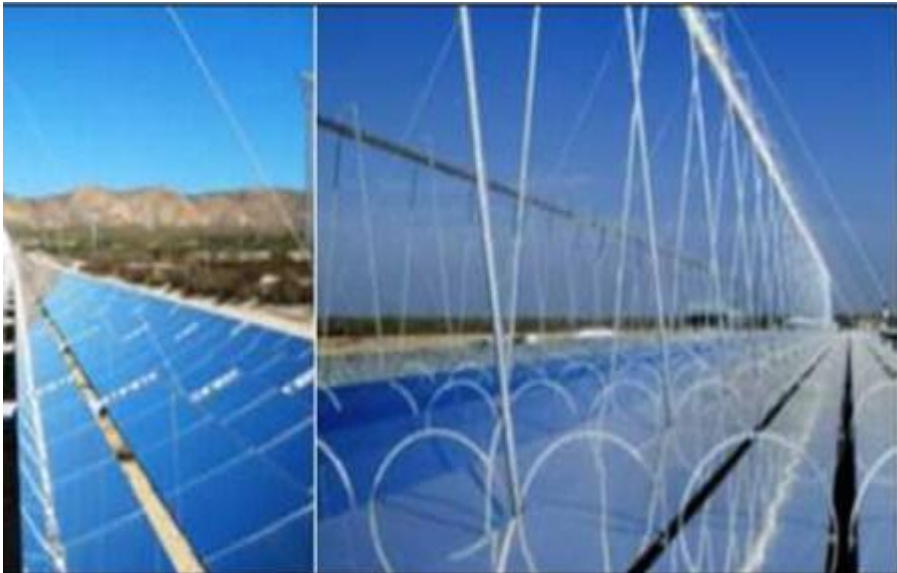
Figure III. 6: Champ de miroirs Construit par NOVATEC-BIOSOL
