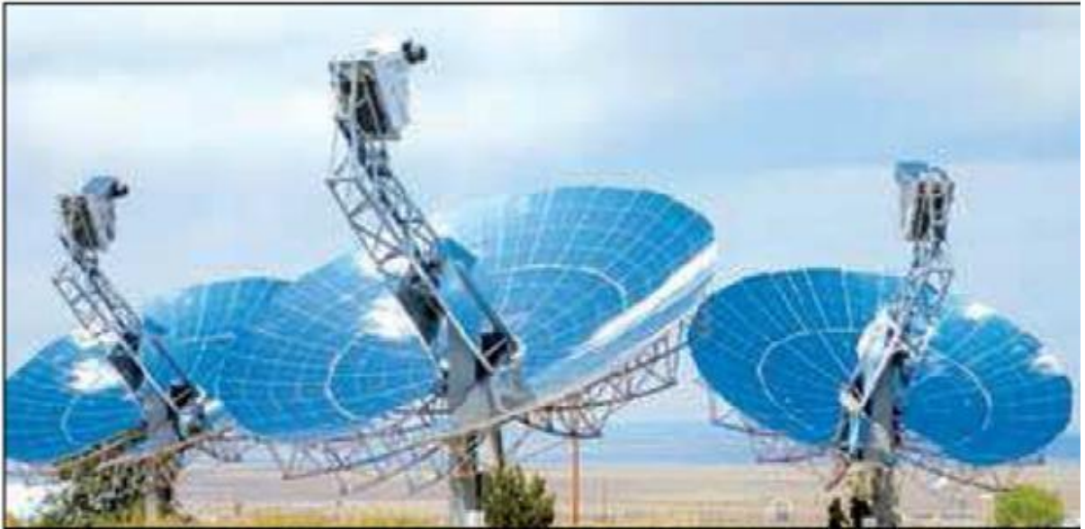
Figure III.7 Capteur parabolique avec moteur Stirling
