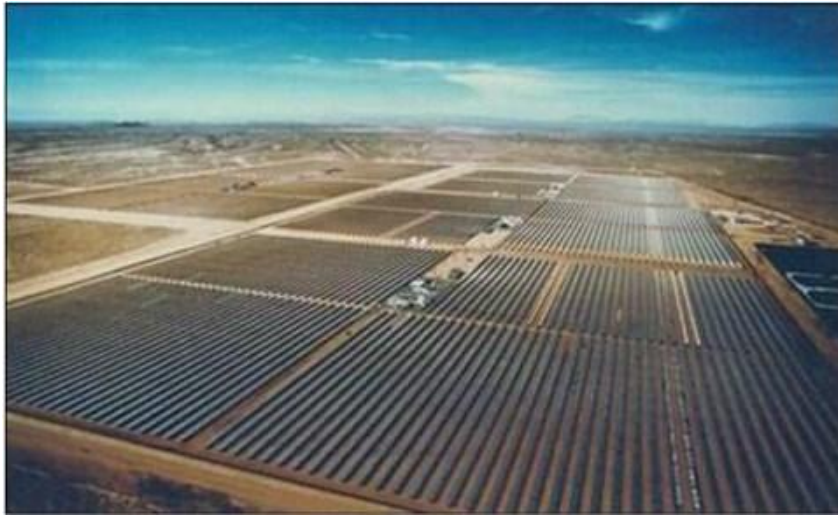
Figure III.8 : Vue des centrales solaires SEGS III-VII de Kramer Junction en Californie de puissance 30Mwchacune.
