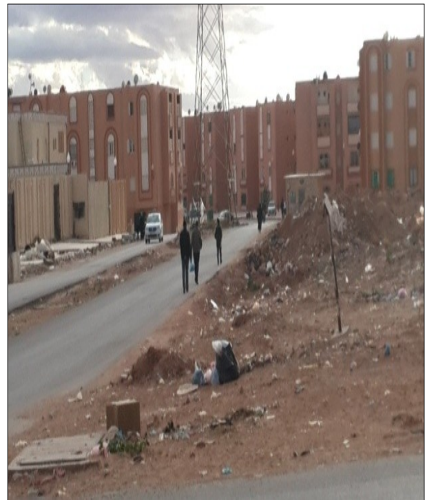
Photo n°21 : les déchets de chantier Source : les auteurs
