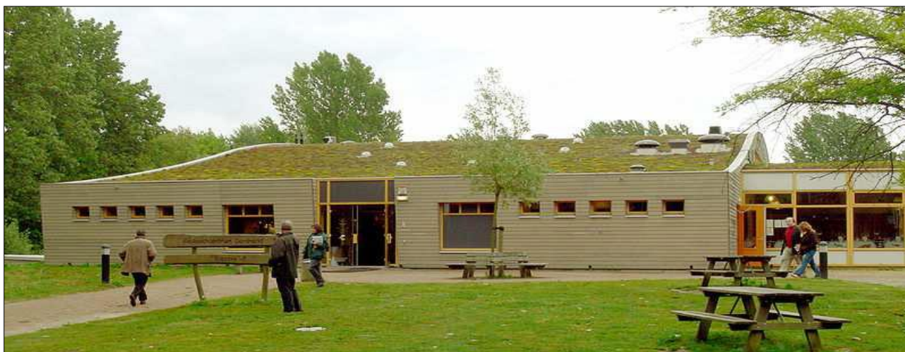
Photo N°11 : Toiture végétalisée extensive (sédums), du centre d'interprétation de la Nature, Parc national du Biebosch.
