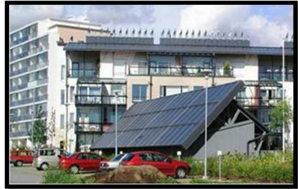
Photo n°13 : toiture avec des panneaux de solaire
