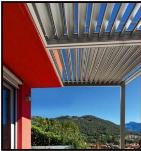
Figure 10 : brise-soleil horizontaux extérieurs Source : A B C - E A Marseille et J. J. Délétère-
