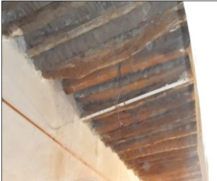
Fig. III .A.20 : les anciennes toitures du mosquée el ATIK a ZGAG EL HADJAJ / les auteurs
