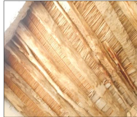
Fig. III .A.21 : Les anciennes toitures à la ville Laghouat /les auteurs
