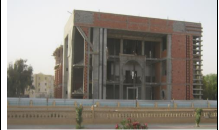
Fig. III .A.37: Construction en brique industrielle / les
