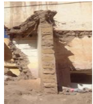
Fig. III .A.10:la forme rectangulaire de mur a chtit Laghouat/les auteurs
