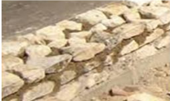
Fig. II.3: utilisation des pierres avec le mortier -colle [12]
