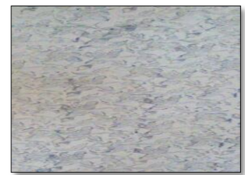
Fig.32 : le crépissage traitement de mur / les auteurs
