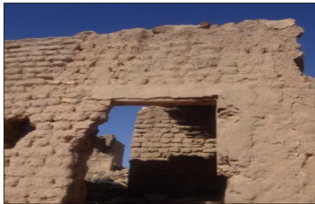
Fig. III .A.22: utilisation un tronc du palmier comme un linteau a ZGAG EL HADJAJ / les auteurs
