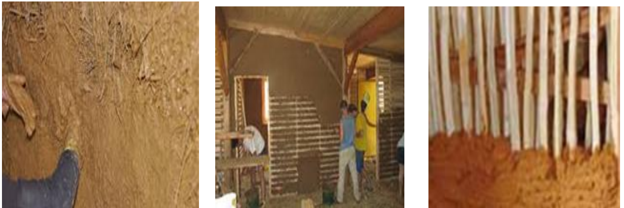
Fig. II. 18 : technique de construction en torchis [17] (traité par les auteurs)
