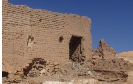
Fig. III .A.36 : Construction en terre – ZGAG EL HADJAJ / les
