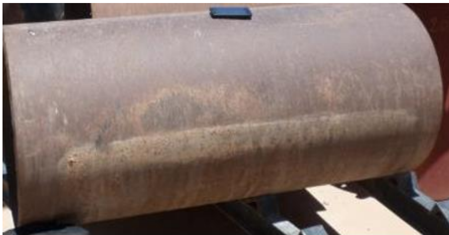
Figure III.8. Photos de pipeline avant découpage
