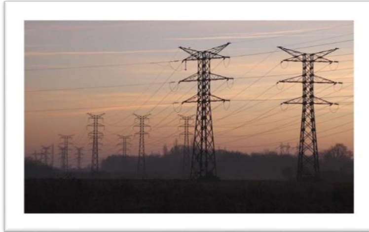
Figure (1.6) - ligne de transmission à double circuit avec tours treillis autoportantes.
