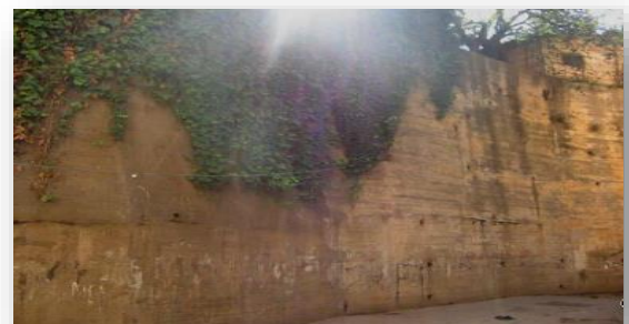
Figure 40: Image apparaît les contraintes du site Source Exposé Sur l'architecte Fernand Pouillon Université de Sétif
