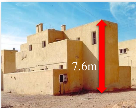
Figure 107: Les logements de cité Abas 1980 La Source : https://archnet.org/sites/68/media_contents/10373
