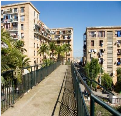
Figure 29:Diar el Mahcoul - Source : https://fr.wikipedia.org/wiki/Fichier:Alger_Diar-El-Mahcoul_IMG_1147.JPG
