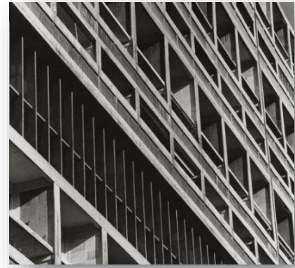
Figure 88: Le rythme des loggias sur la façade ouest et les brise-soleils du niveau des services communs. Source : L'Unité d'habitation de Le Corbusier l'unité de l'habitation de Marseille p :94
