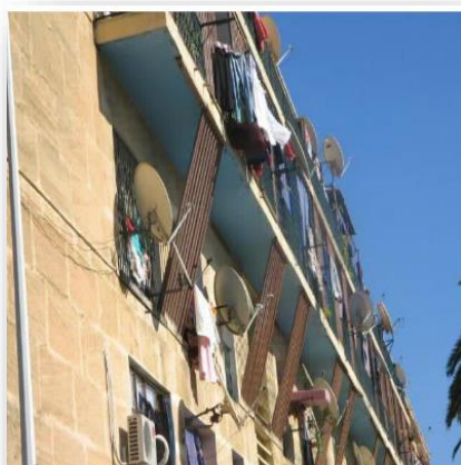
Figure 66: traitement des façades (avec les balcons et porte à faux)
