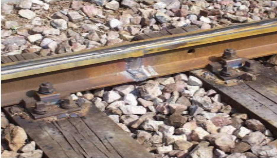
Figure IV.6 : photo d'une barre soudée
