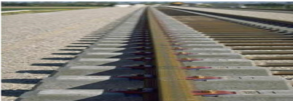
Figure IV.11 : Travers en Bi bloc
