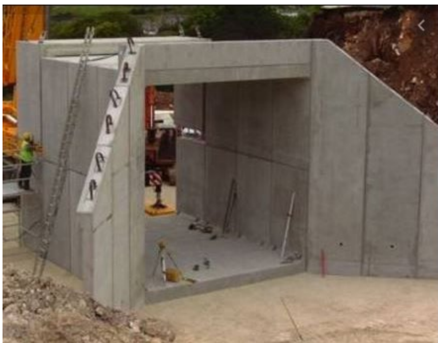
Figure VII.1 : Travaux ouvrage d'art (type dalot)
