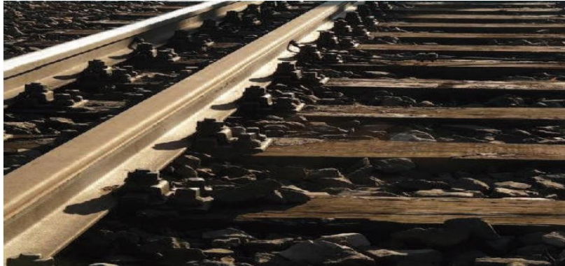
Figure IV.10 : Travers en bois
