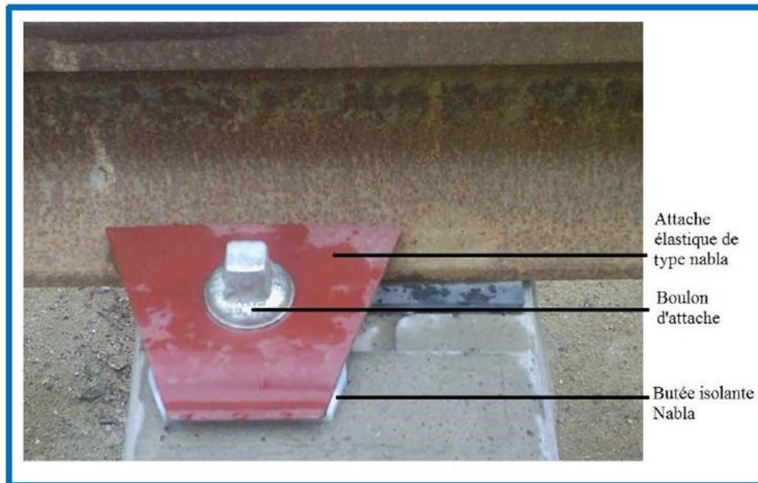
Figure IV.18 : Les éléments d'une attache de type Nabla.
