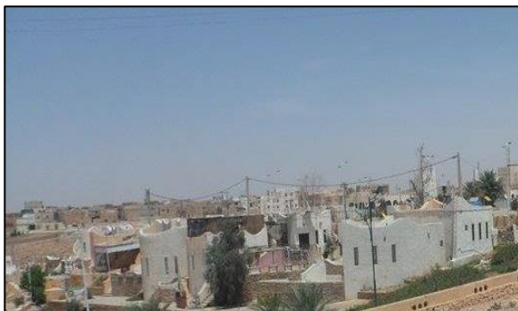
Figure N28 : Les magasins
