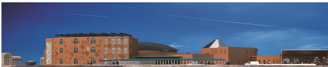
Figure N18 : Façade principale, Source : Auteur
