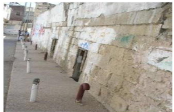
صورة 38 و 39: تهوية الخندق المحيط بالسور الخارجي للجامع العمري الكبير.
