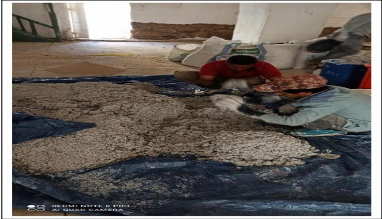
صورة 22: تحضير مواد البناء لترميم المبنى.
