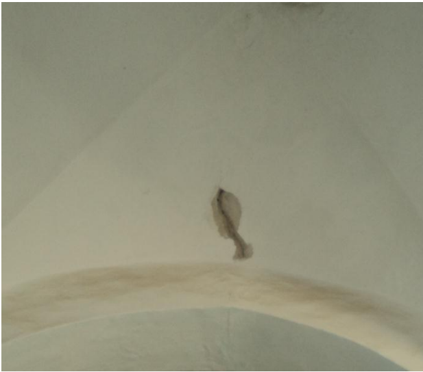
الصورة 35 : توضح تأثير الرطوبة على مستوى القباب من الداخل لقاعة الصلاة
