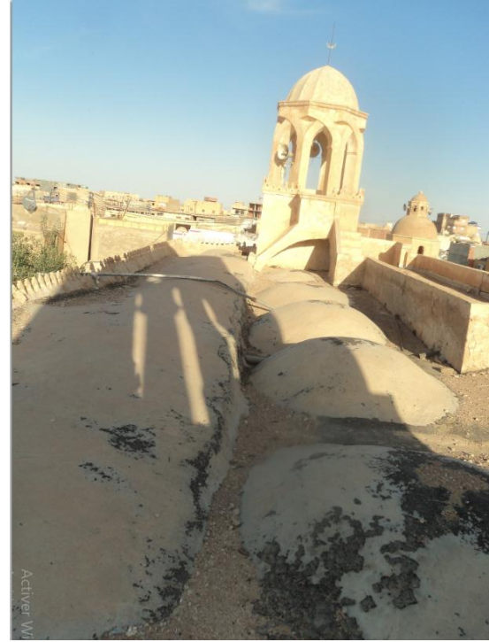
الصورة 26 : توضح تأثير الرطوبة و التشققات على مستوى سقف المسجد
