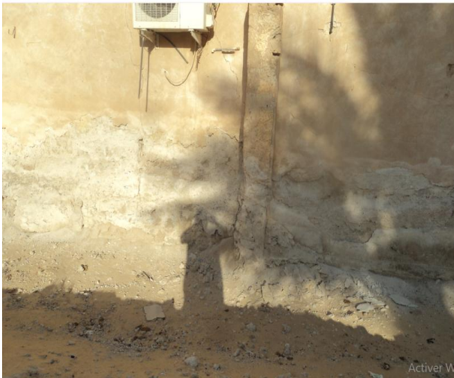
الصورة 16 : توضح تأثير الرطوبة و التصدعات على مستوى قاعدة الجدار الغربي الخارجي للمسجد
