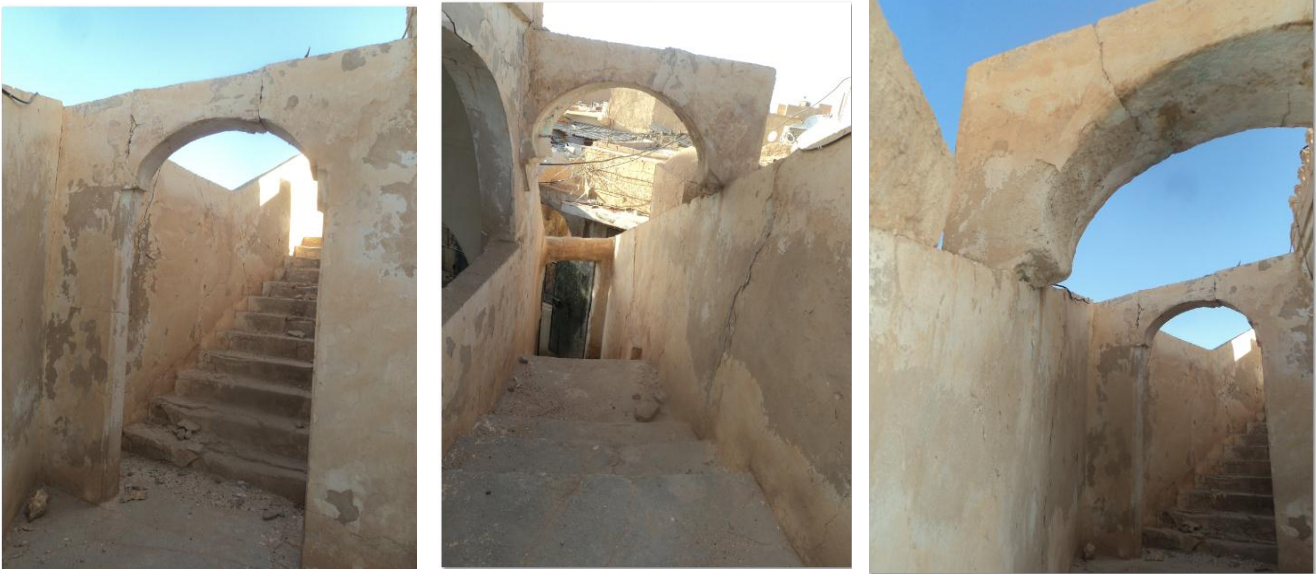
الصورة 25 : توضح تأثير الرطوبة و التشققات على مستوى أعلى السلم بالمسجد
