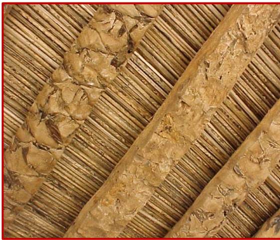
الصورة 8. استعمال جذوع النخيل في بناء الاسقف في
