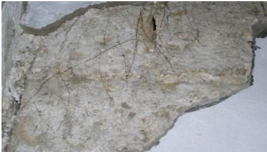
صورة 35: المشاكل الناتجة عن نمو النباتات على جدران المبنى.
