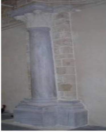
(ب): إزالة طبقة الخرسانة عن بدن العمود
