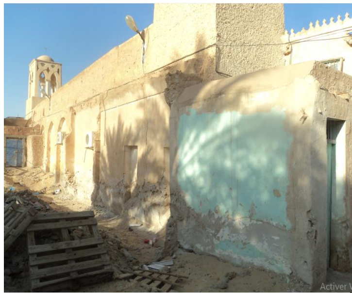
الصورة 39. الواجهة الغربية لمسجد سيدي مسعود
