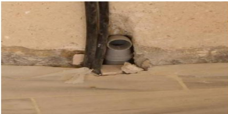
صورة 38 و 39: تهوية الخندق المحيط بالسور الخارجي للجامع العمري الكبير.
