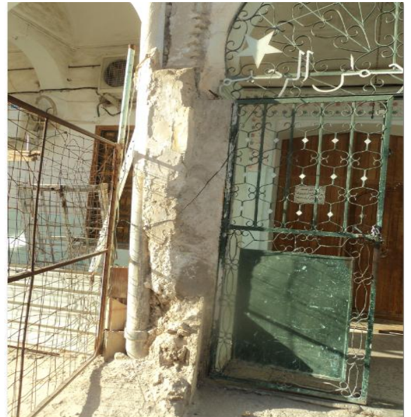
الصورة 11 : توضح تاثير الرطوبة الجدران و اماكن الترابط مع الابواب للمسجد
