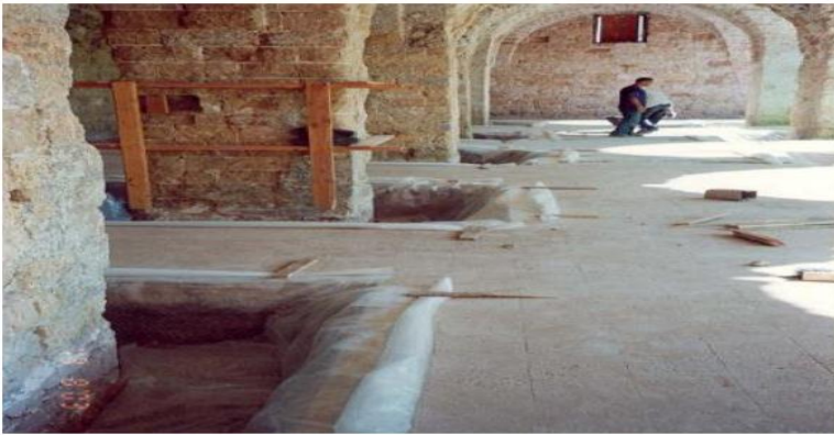
صورة 37: أعمال تنفيذ الخندق المحيط بالحوائط.
