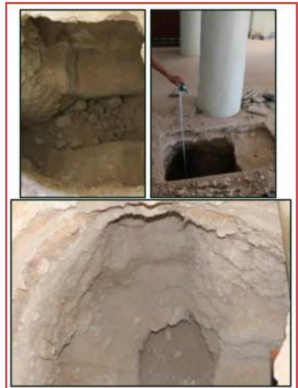
الصورة 40 : توضح عمق الحفر للكشف عن الرطوبة
