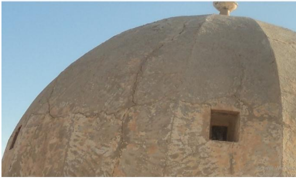
الصورة 30 : توضح تشققات القباب على المستوى الخارجي بسقف المسجد
