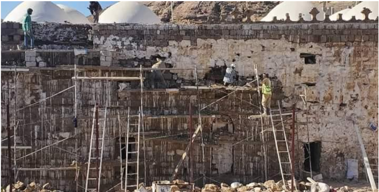
صورة 30: مناظر خارجية لأشغال ترميم المبنى.
