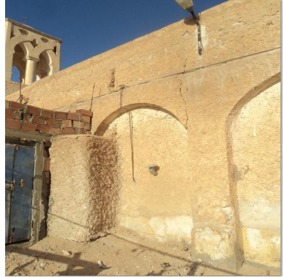
الصورة 16 : توضح تأثير الرطوبة و التصدعات على مستوى قاعدة الجدار الغربي الخارجي للمسجد
