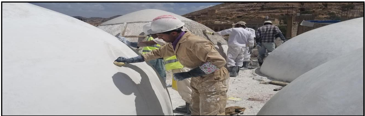
صورة 27: تنعيم الطبقة الأخيرة الخارجية للقباب.
