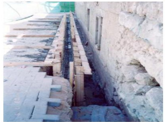
صورة 36: أعمال تنفيذ الخندق المحيط بالسور.
