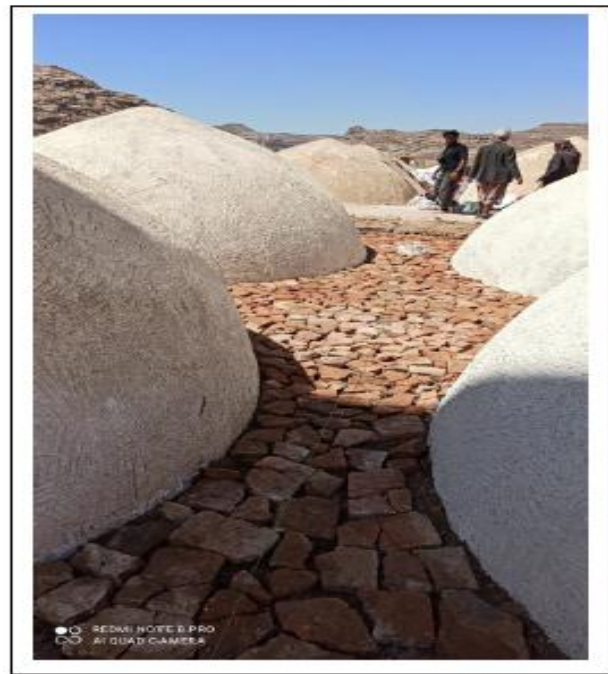
صورة 25: تحضير طبقات العزل لترميم السقف.
