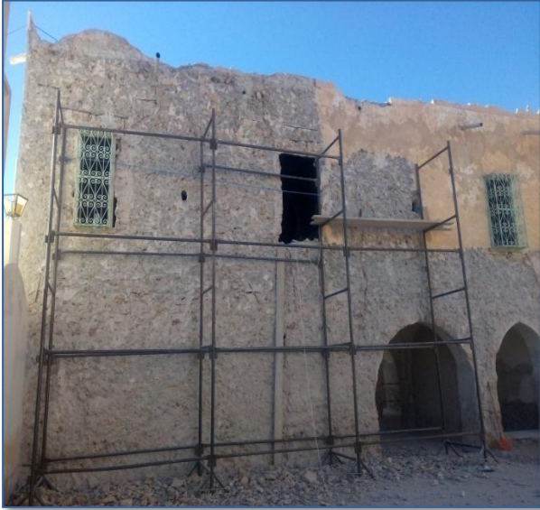
الصورة 19. طريقة استعمال السرير في البناء بالحي العتيق الاعشاش المصاعبة بالوادي
