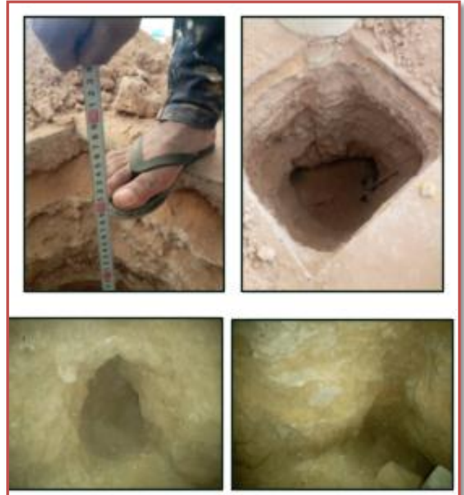
الصورة 41 : توضح عمق الحفر للكشف عن الرطوبة
