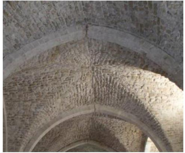
صورة 43: تعبئة الشقوق بالمونة التي تحتوي على قطع الفخار. صورة 44: طبقة القسارة التي تحتوي على الكركار.
