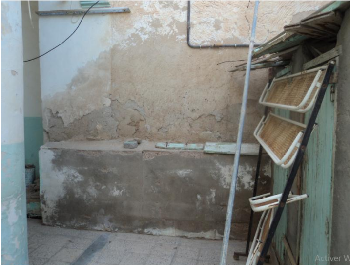
الصورة 20 : توضح الجدار الخارجي جهة الفناء الشمالي للمسجد
