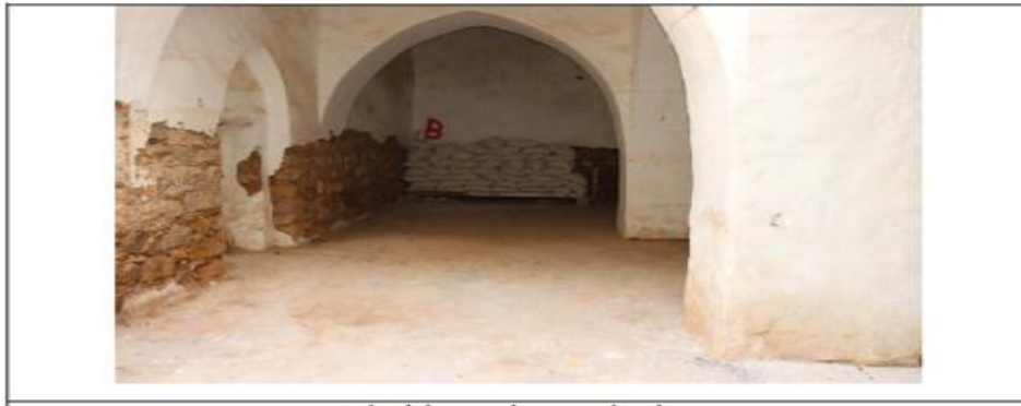
صورة 04: توضح موقع المجس رقم (1) قبل الحفر.... Area A
