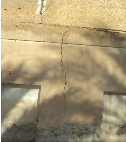
الصورة 15 : توضح تأثير الرطوبة و التصدعات على مستوى الجدار الغربي الخارجي للمسجد
