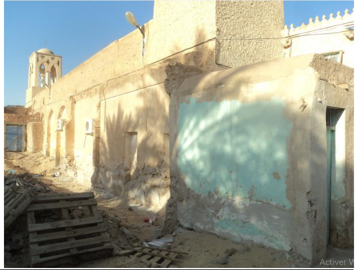
الصورة 15 : توضح تأثير الرطوبة و التصدعات على مستوى الجدار الغربي الخارجي للمسجد
