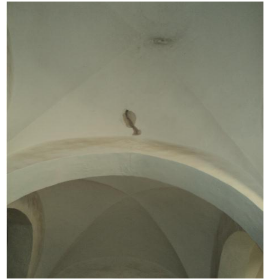
الصورة 35 : توضح تأثير الرطوبة على مستوى القباب من الداخل لقاعة الصلاة
