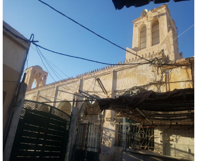
الصورة 37 : مداخل مسجد سيدي مسعود الجهة الجنوبية
