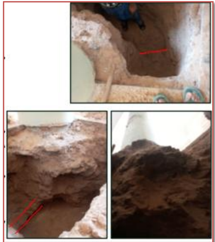
الصورة 42 : توضح عمق الحفر للكشف عن الرطوبة
