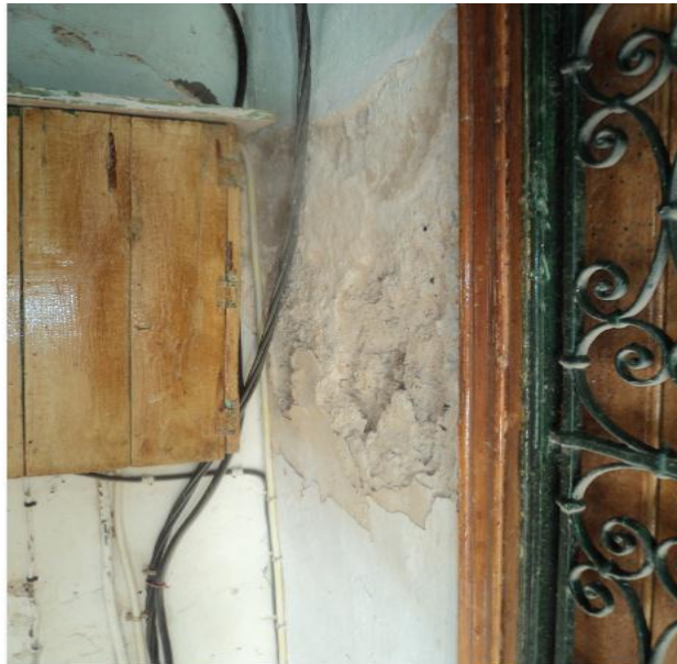
الصورة 11 : توضح تاثير الرطوبة الجدران و اماكن الترابط مع الابواب للمسجد
