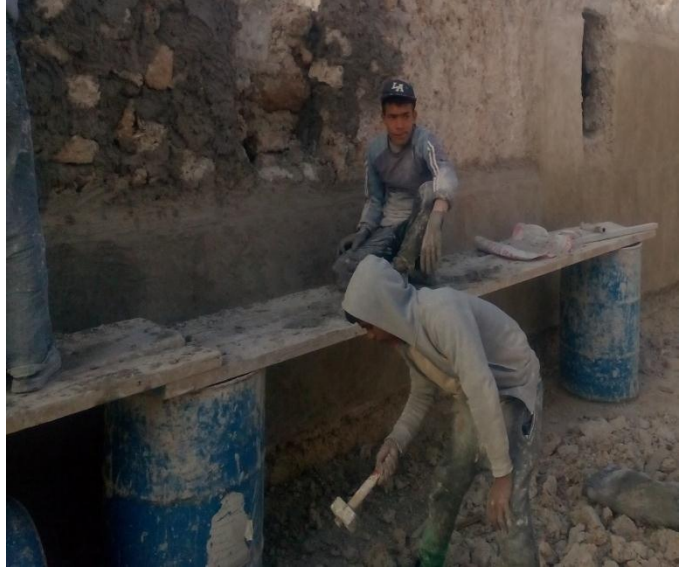
الصورة 19. طريقة استعمال السرير في البناء بالحي العتيق الاعشاش المصاعبة بالوادي
