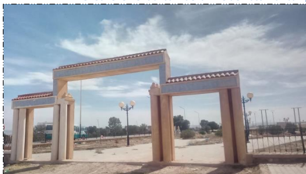
Fig.33 : vu sur l'espace public N05 Source : par auteur
