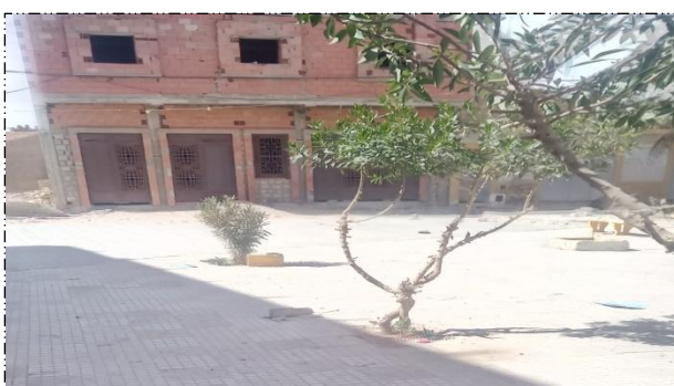
Fig.27 : vu sur l'espace public N03 Source : par auteur
