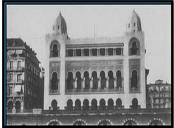
Fig. n°10 La préfecture d'Alger 1913
