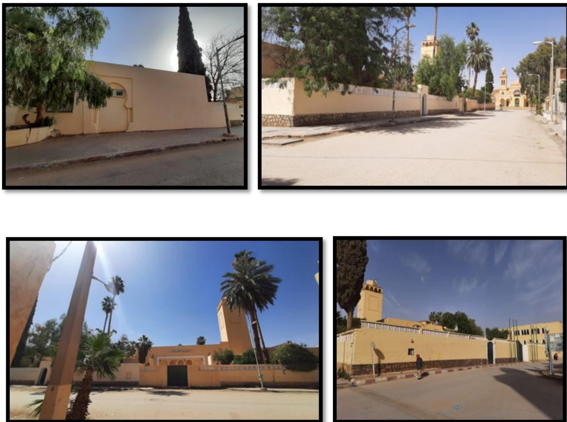
Figure n°53 : vue de l'extérieur
