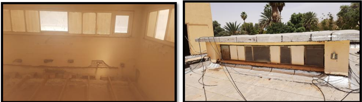
Figure n°44 : l'atrium- source auteur
