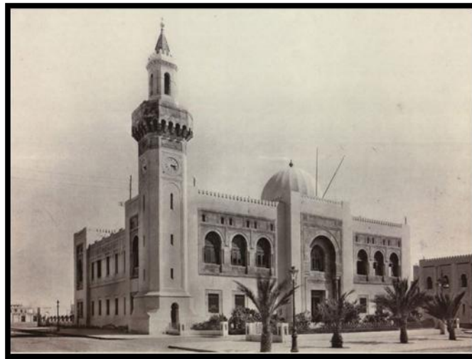
Fig. n°22: Façade principale, Hôtel de Ville de Sfax. Vers 1906.
