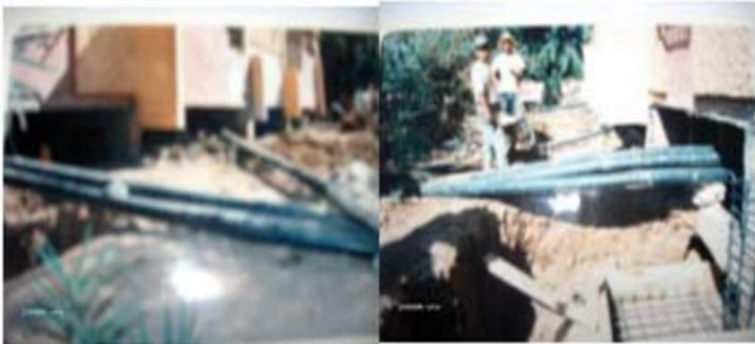
Figure III.13: Nouvelles conduites d'égout pour évacuer les eaux usées
