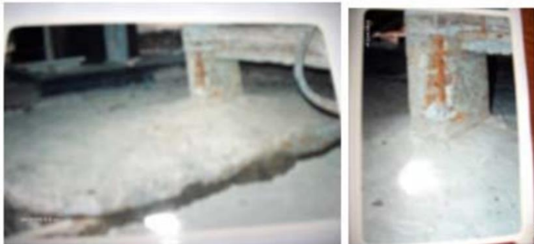
Figure III.12: Coulée de fondation sans coffrage [26].
