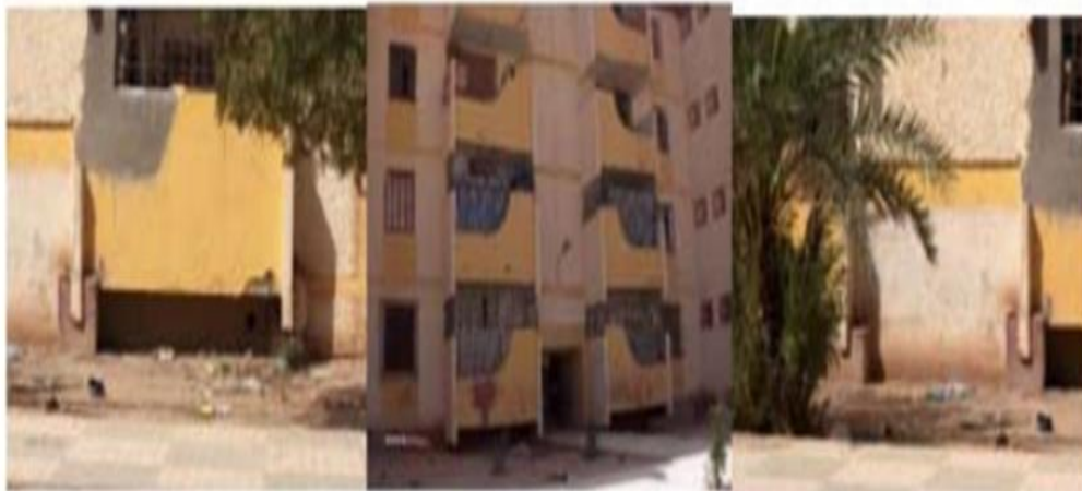
Figure III.18 : Bâtiment après réparation [26].
