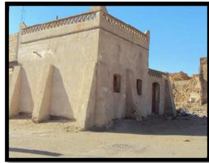
Figure I.10: Ecole coranique réhabilitée ksar Mestaoua
