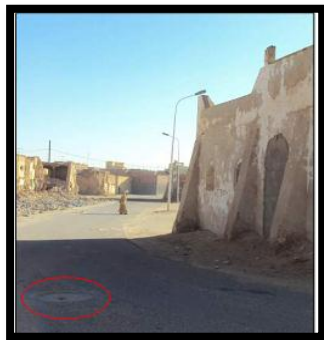
Figure I.07: Implantation de réseaux divers (Ksar Mestaoua)
