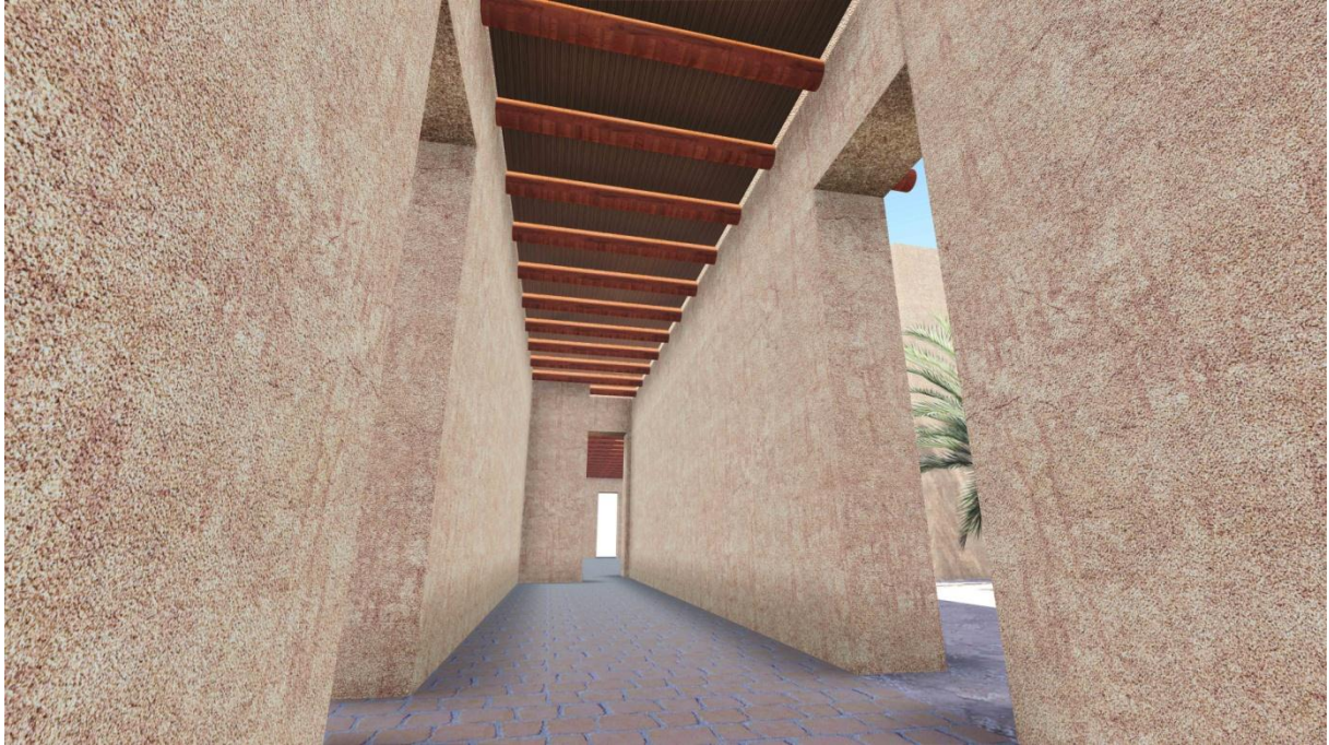
Figure.III.17 : vue après la restauration du plancher dans le couloir et traitement de fissuration des murs et traitement de sol
