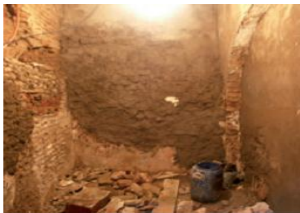
Figure. III.18 : Technique de mise en œuvre de traitement des fissurations au niveau des murs
