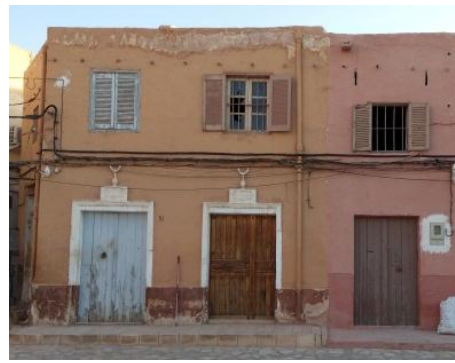
Figure 92: infiltration des eaux pluviales et eaux usées. Pris par les étudiants
