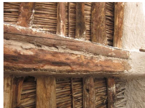
Figure 152 : plancher en troncs de palmier. [30]
