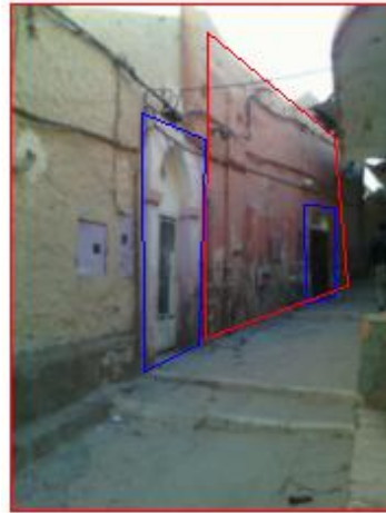
Figure 74: façade d'habitation. Pris par les étudiants
