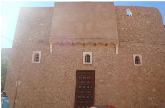
Figure 22: la façade de la maison. [20]
