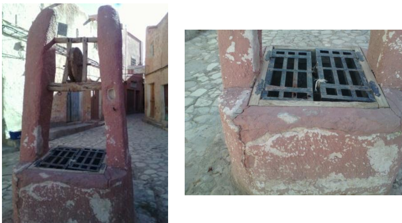
Figure 106: dégradation de puits. Pris par les étudiants
