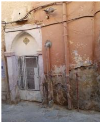
Figure 92: infiltration des eaux pluviales et eaux usées. Pris par les étudiants
