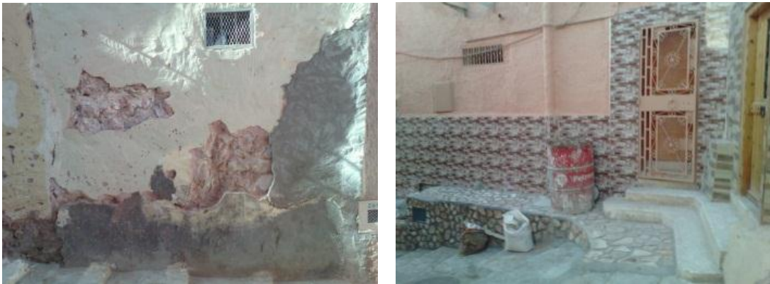
Figure 87 L'utilisation de ciment et de Fayence. Pris par les étudiants
