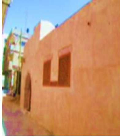
صورة رقم 6: توضح الواجهة الرئيسية للمبنى دم- نادر جواد النمرة في الدراسة السابقة
