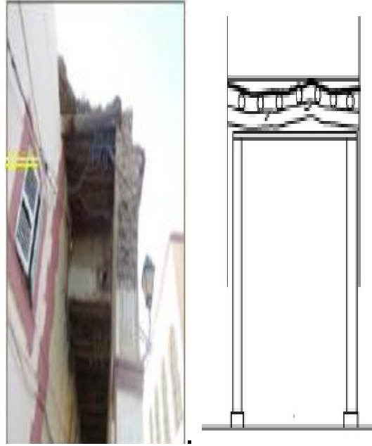
صورة رقم 99: توضح كيفية دعم السقف بدعامات شاقولية المصدر : دراسة مطابقة القصور إلى مخطط الحماية ppsmvss
