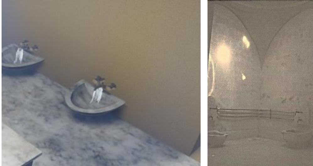
صورة رقم 114: توضح تركيب أنابيب الماء في الحمامات العثمانية
