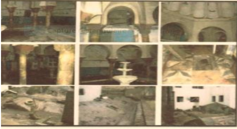
صورة رقم 35: توضح مظاهر التلف في حمام الصباغين قبل عمليات إعادة التأهيل
