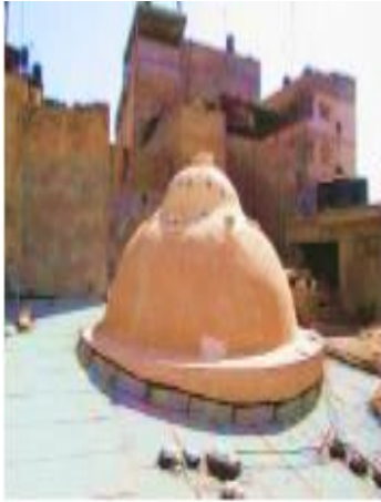
صورة رقم 7: توضح القبة الرئيسية وبعض العقود المصدر: دم- جواد النمرة في الدراسة السابقة
