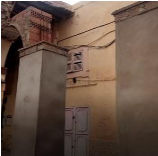
صورة رقم 100: يوضح كيفية تدعيم الأقواس المصدر : دراسة مطابقة القصور إلى مخطط الحماية ppsmvss
