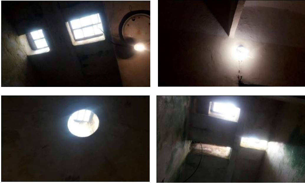
صورة رقم 128: توضح الإضاءة داخل الحمام
