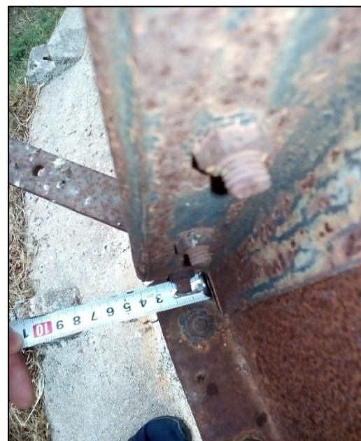
Figure 67 : Mesure de la bordure d'assemblage
