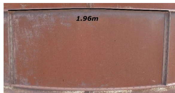
Figure 61 : Le résultat d'extraction du meilleur cylindre ; Figure 62 : Une virole du silo de stockage
