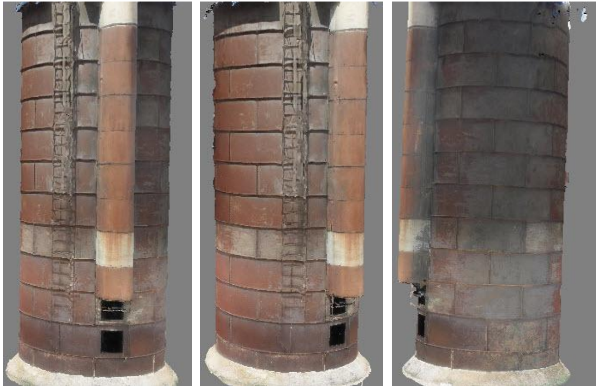
Figure 56 : Résultat de construction du modèle tuilé
