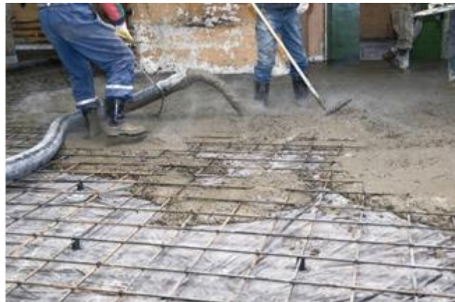
Figure 1.5. Pompage de béton autoplaçant
