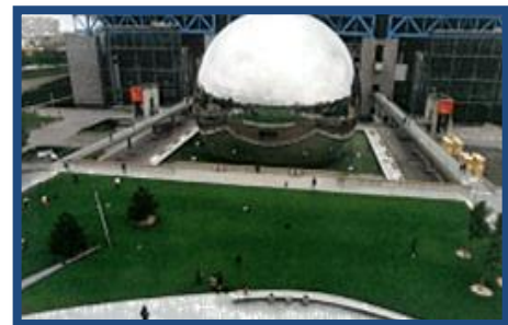
Figure(73):La Géode source : wikipédia.org
