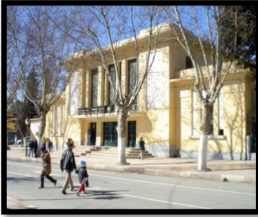
Figure(13): L'ancienne poste source : www.Sétif.com
