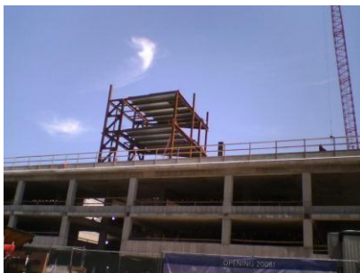
Figure 35: vue du parking public au cours d'exécution
