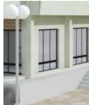
Figure 45: photo de la brique dans la façade
