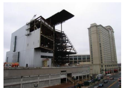
Figure 36 : vue du projet au cours d'exécution
