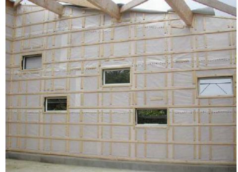
Figure20 :vue intérieure de la structure en bois
