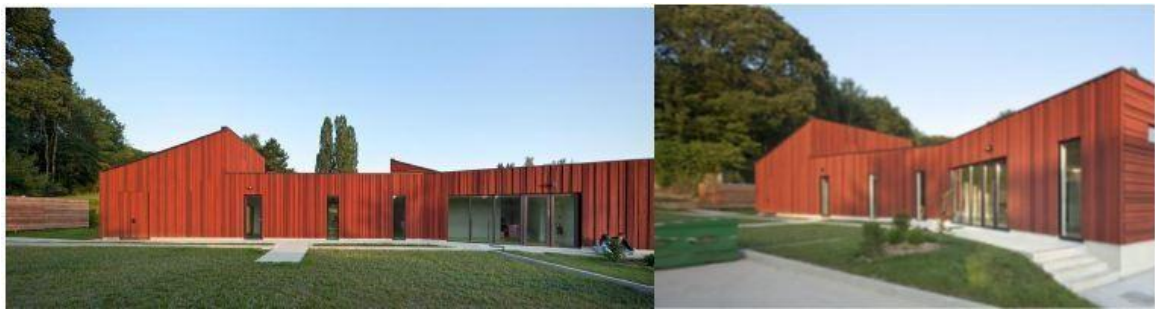
Figure12: Façade Sud Est
