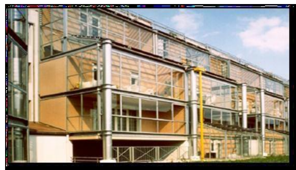
Figure 19 : Protection Solaire par les espaces tampon Source : www-energie2.arch.ucl.ac.be
