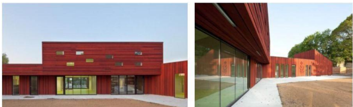
Figure13: Façade Sud Ouest
