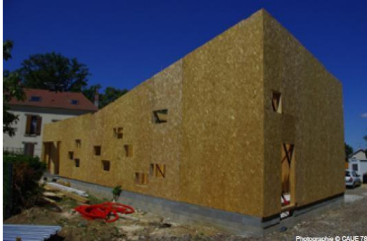
Figure19 :vue extérieure des panneaux OSB
