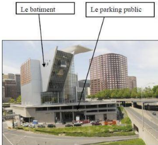
Figure 26 : photo présente l'implantation du Bâtiment sur le parking public
