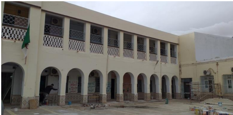
Figure III 52 L'extension des classes à l'étage Source auteur
