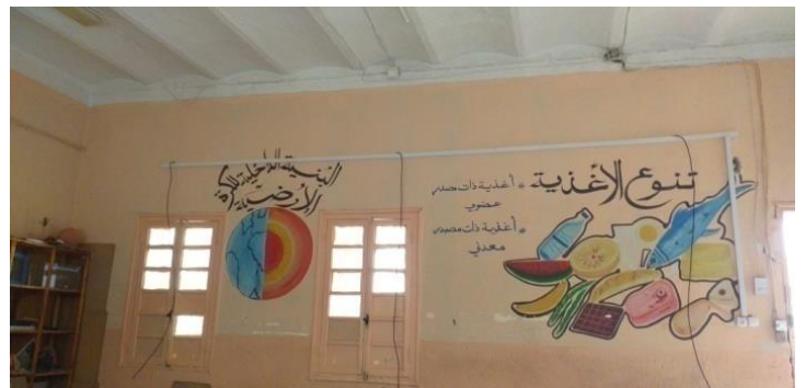
Figure III .49 Photo du plancher Source auteur
