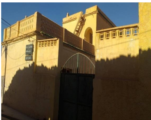
Figure II.18: la façade principale de l'école
