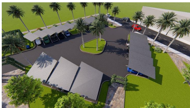
Figure 120 : panneaux solaire au niveau de parking voitures
