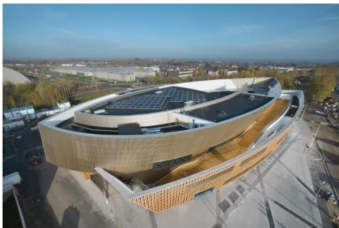
Figure 16 : Vue du façade sud de MICX Source : www.mons.be
