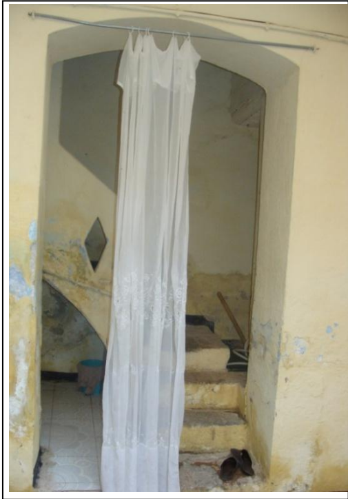
Figure III.15: Cage d'escalier du cas d'étude (Source: auteur )
