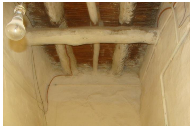
Figure III.14: revêtement du plafond (Source: auteur )
