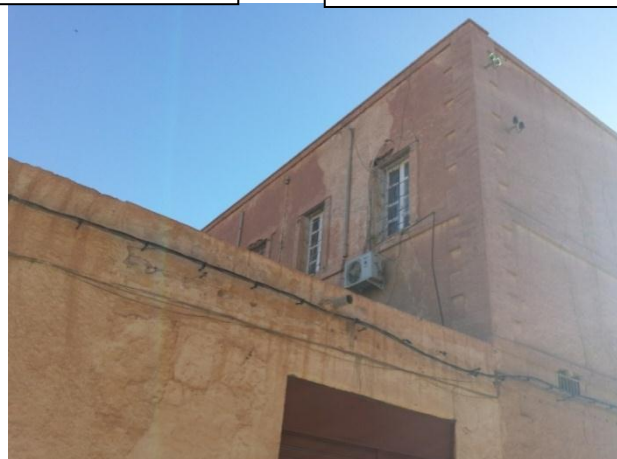
Photo27: façade latérale de la maison. Source: bureau d'étude TEEC, ingénieur: Lakhdar Mohamed.
