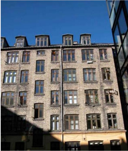
Photo1: Les façades des immeubles en cours de réhabilitation. Source: PDF le quartier Vesterbro à Copenhague au Danemark.
