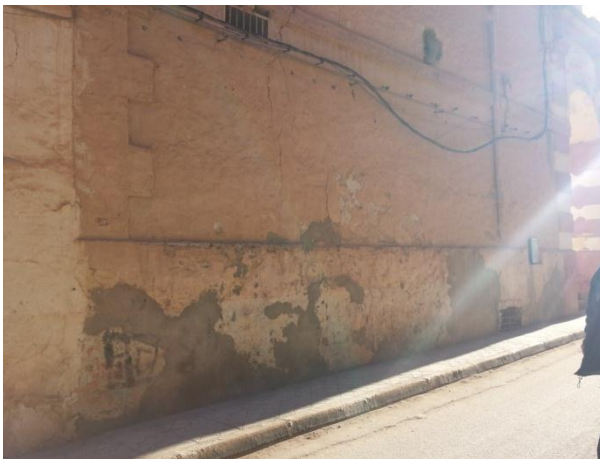
Photo25: façade latérale de la maison. Source: bureau d'étude TEEC, ingénieur: Lakhdar Mohamed
