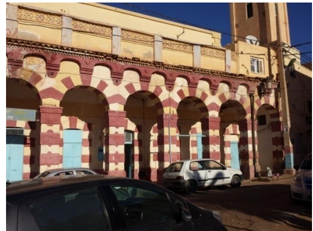
Photo26: façade principale de la maison. Source: bureau d'étude TEEC, ingénieur: Lakhdar Mohamed
