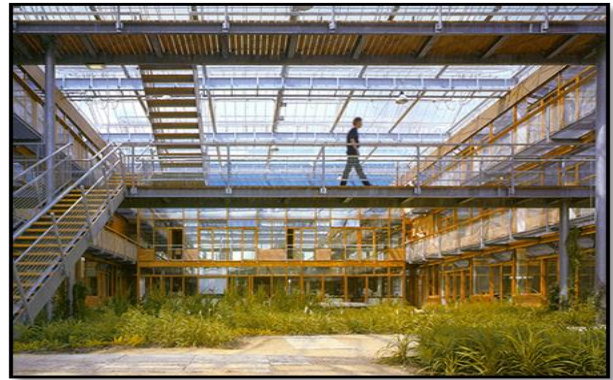
Fig.II-12 Vue sur les passerelles [Source : Dominique Muller 2001]
