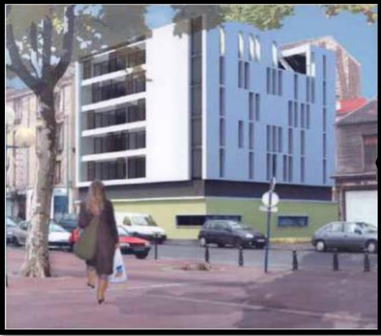
الشكل 13: مبنى لسكنات و تجارة
