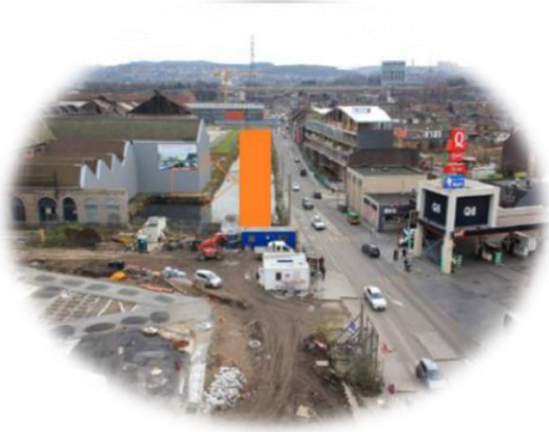
الشكل 19: هدم مبنى CMI
