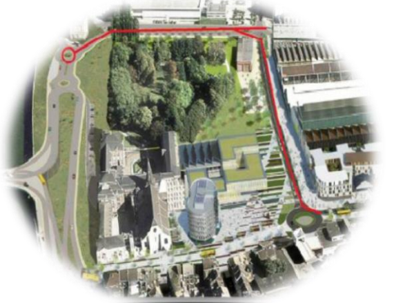
الشكل 20: توسيع Rue Cockerill: تقدماً لأعمال، سبتمبر 2014
