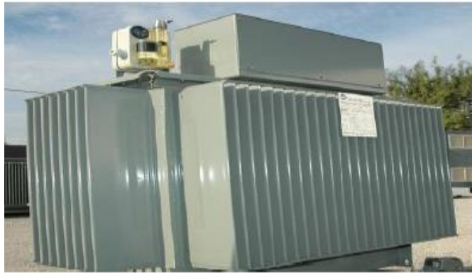
Figure (I.6) La cuve d'un transformateur de puissance.
