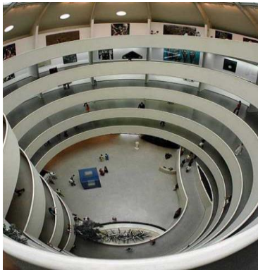
Photo 9: rampe centrale de guggenheim
