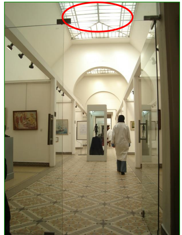
Figure 88 : Éclairage naturel Zénithal a travers des verriers
