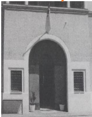
Photo 38:L'entrée latérale de service
