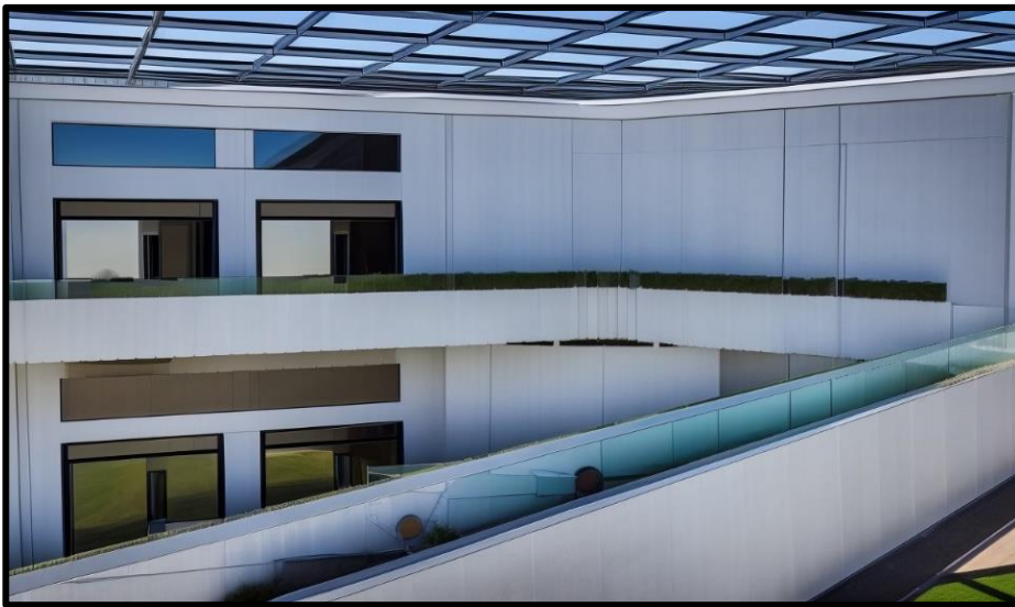
Figure 15 : vue intérieure sur l'entité de recherche. Source : L'auteur
