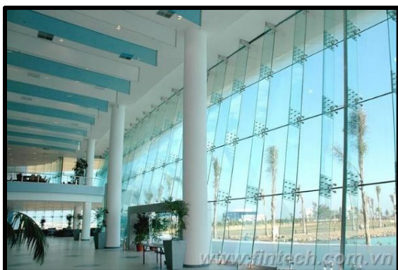
Figure V-35 : mur-rideau Source : https://fintech.com .
