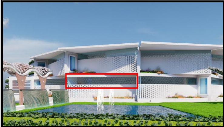
Figure V-26 : vitrage solaire photovoltaïque (façade Sud) Source : L'auteur
