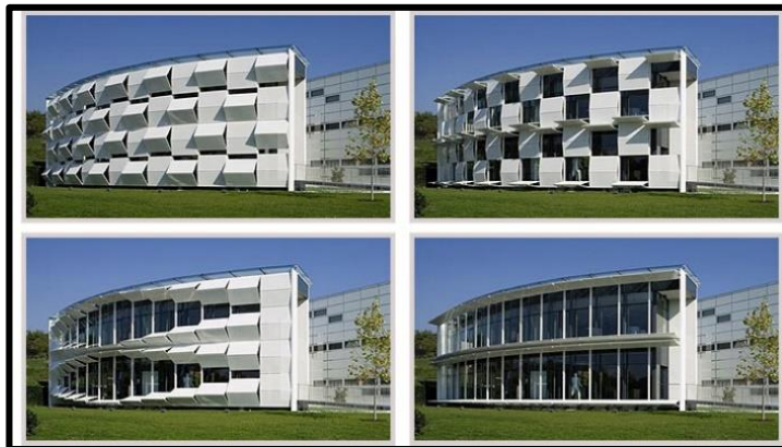
Figure V-33 : Façade cinétique Source : https://www.alucobond-euro
