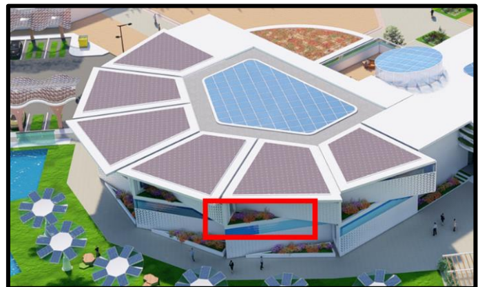
Figure V-03 : Terrasse végétalisée (façade sud) Source : L'auteur.
