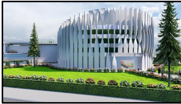
Figure V-41 : Vues sur la structure en béton précontraint Source : L'auteur.
