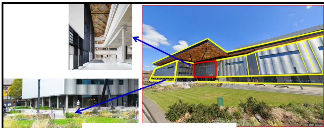
Figure I-27 : la façade principale (sud-ouest) Source : ArchDaily , traité par l'auteur
