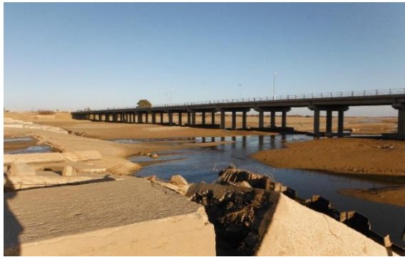
Pont de Barrage de Tadjmout
