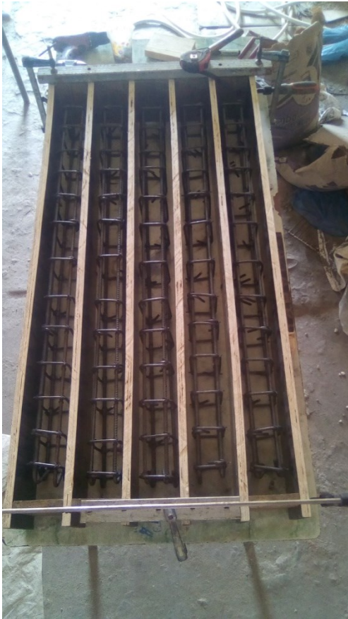
Coffrage en bois pour les poutres 10x15x110cm
