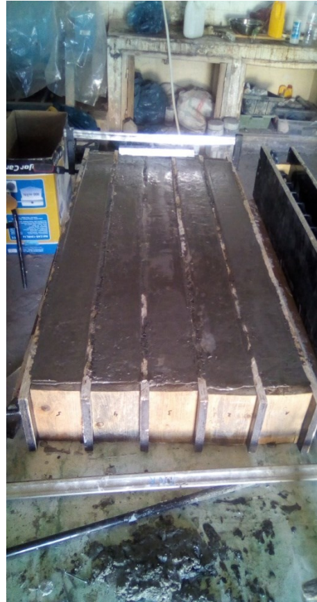
Coulage des poutres
