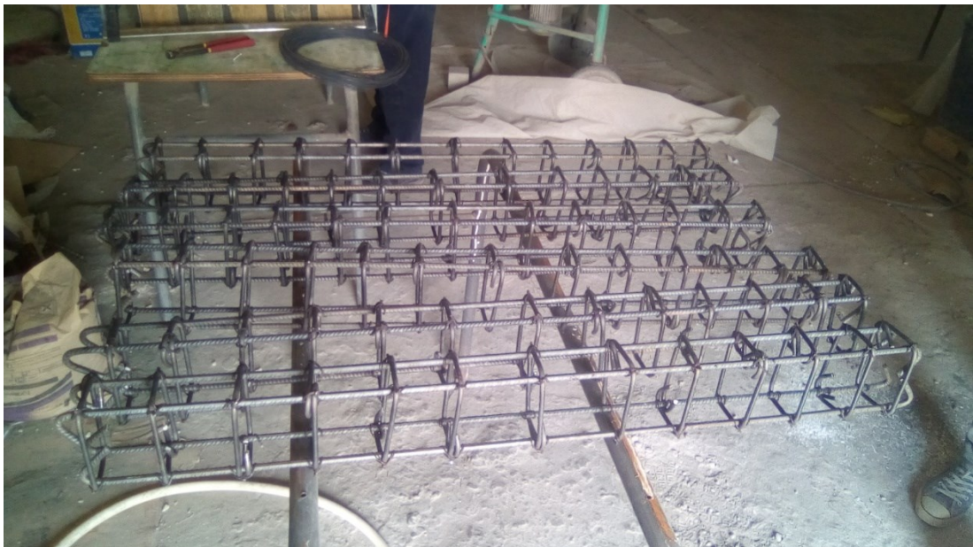
Ferrailage des poutres
