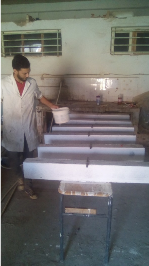
Application d'une couche de vinyl
