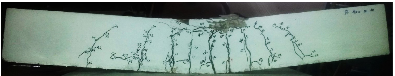
Destruction et fissuration finale de la poutre BCDF10 avec At
