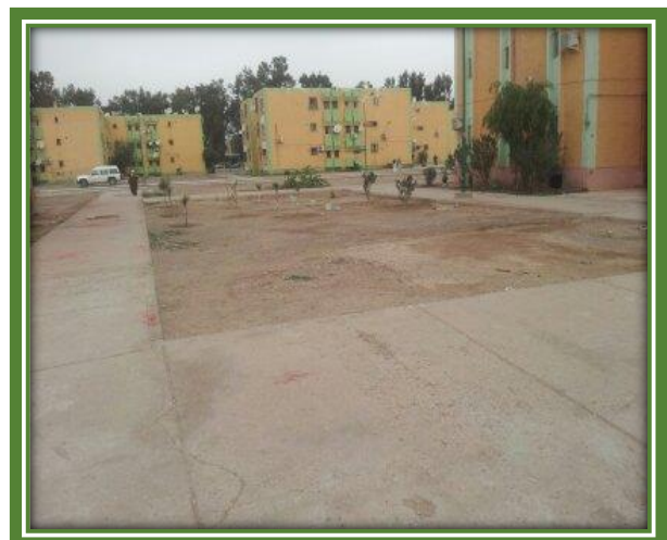
Photos N°43 de la zone Source: prise par l'auteur
