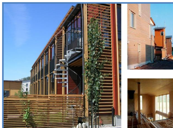
Image N°06: Les matériaux de construction employés. Source https://encrypted-tbn1.gstatic.com .
