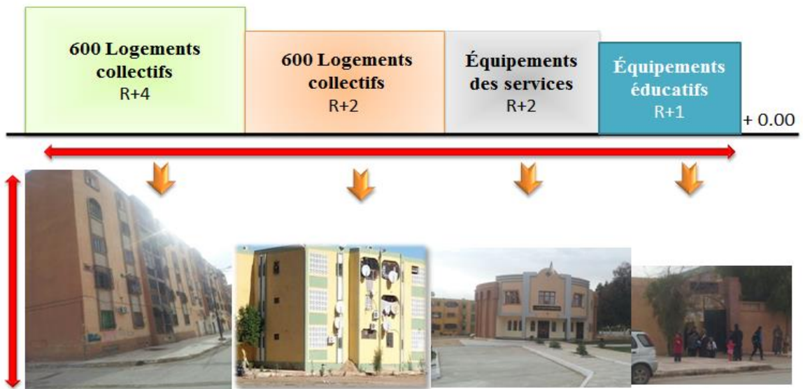
Photos N°25, 26 , 27 , 28,29de la zone ; Source: prise par l'auteur
