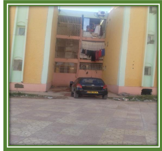
Photos N°41 de la zone Source: prise par l'auteur
