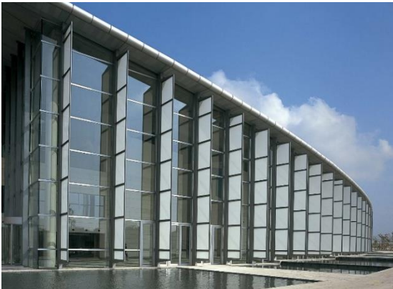
Figure 37 : mur rideau avec protection solaire
