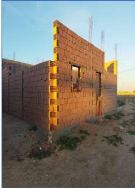
Des maisons en cours de construction
