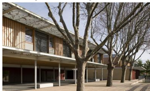
Figure 48 : façade latérale .Source : Tectoniques et Atelier GA Architectes Tectoniques / Dossier de presse -Juin2012.
