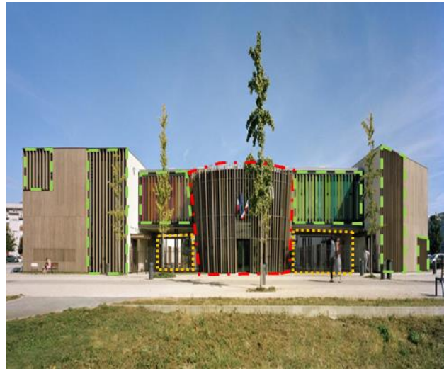
Figure 30: : Analyse de la façade principale de Groupe Scolaire Simone Veil Source : auteur.
