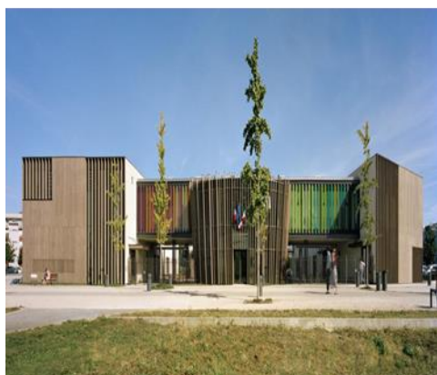
Figure 22 : Groupe Scolaire Simone Veil Source : TEKHNE ARCHITECTURE.
