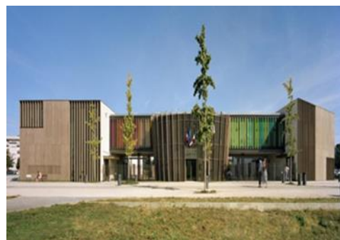
Figure 23 : Groupe Scolaire Simone Veil Source : TEKHNE ARCHITECTURE.
