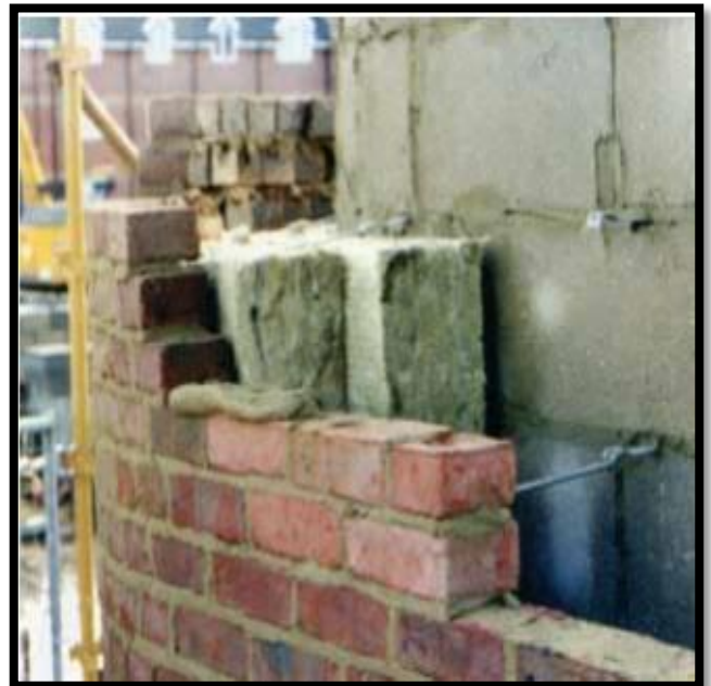
Figure I.10 : matériaux de construction. Source : www.maison-zero-nergy-bedzed.com
