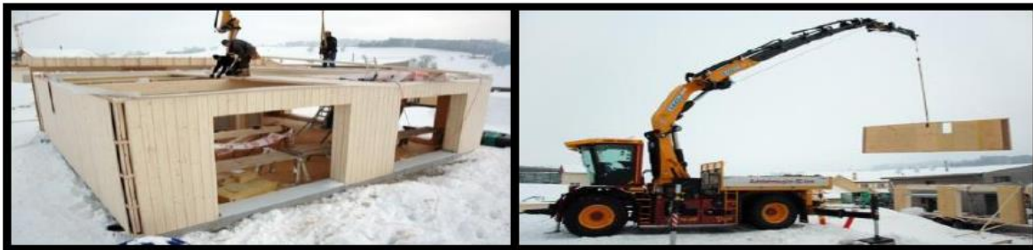
Figure I .47 : photos qui montrent les travaux de réalisation, Source : http://lab-immo.ch/1037-/ Minergie-P-ECO MAISON
