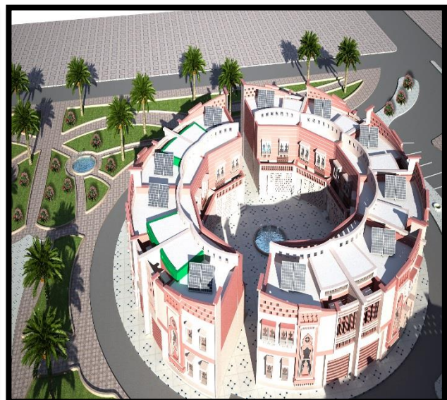
Figure IV.49 : panneaux photo voltaïque Source: Auteur
