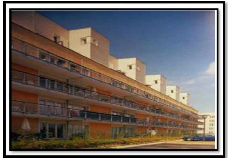
Figure I. 24 : Vue Sur le projet, Source : http://www.reseau-breton-batiment-durable.fr/retour_experience/residence-salvatierra
