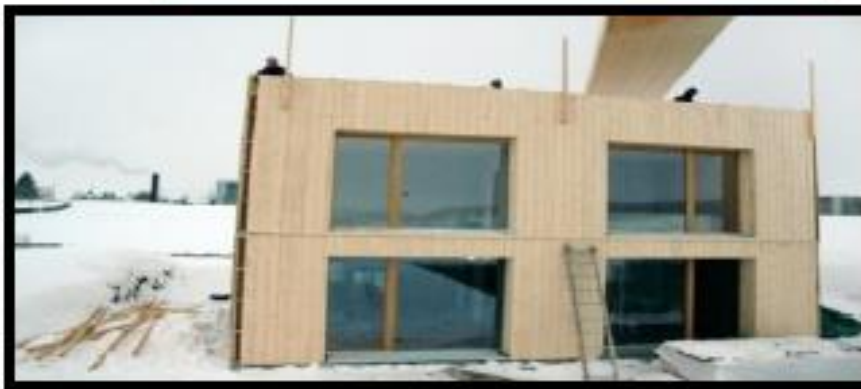
Figure I. 54 : surface vitrée de la maison, Source : http://lab-immo.ch/1037/ Minergie-P- ECO MAISON
