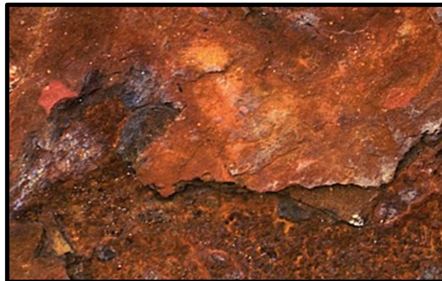
Figure 1 : Image qui présente la Corrosion sèche [9].
