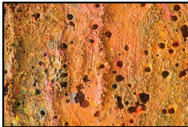
Figure 3 : Image qui présente la Corrosion bactérienne [11].
