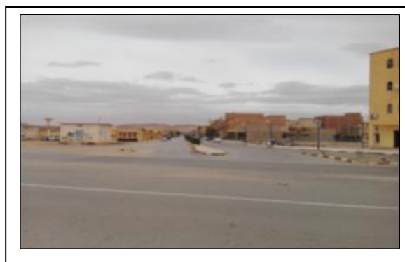
Figure 17 : Sud-ouest : nouvelle extension POS 18.
