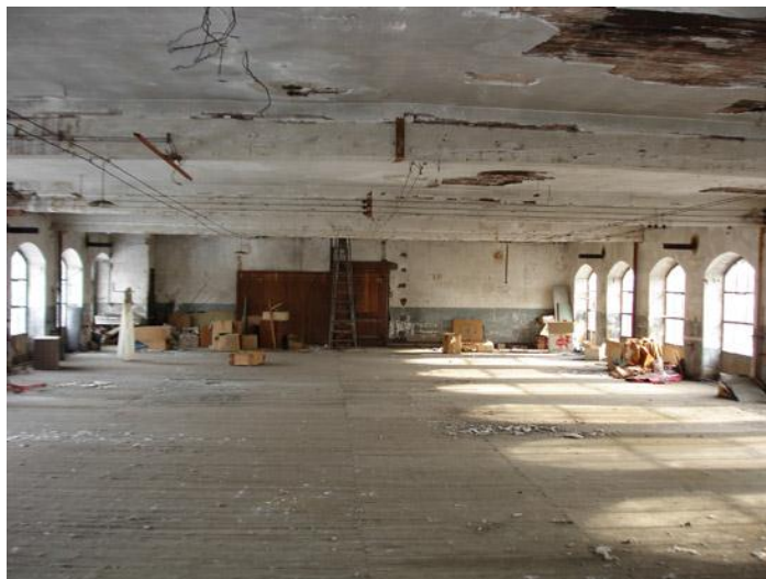
Fig. II.12. Vue sur l'état initial de l'un des plateaux [31]
