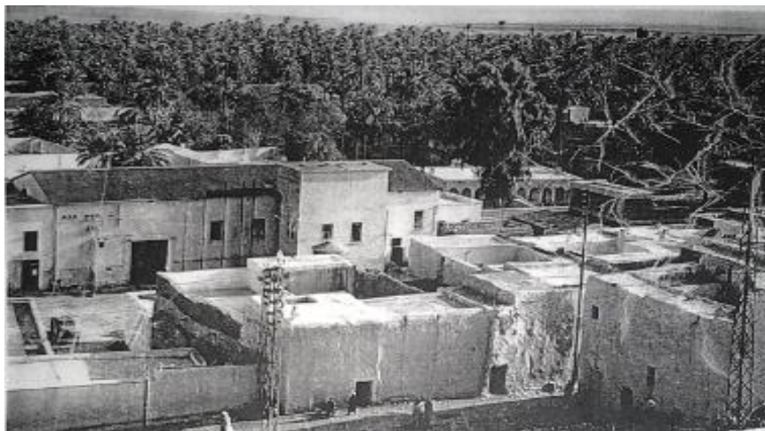
Fig.III.7 : Vue globale sur la Centrale avant 1957 [3]
