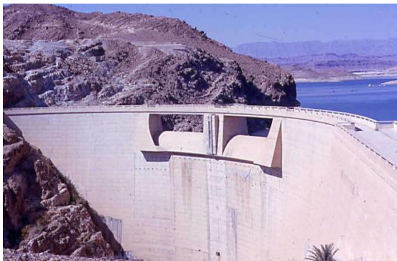
Fig. II.3. Le barrage hydraulique de Foug El Ghorza (Biskra) [24]
