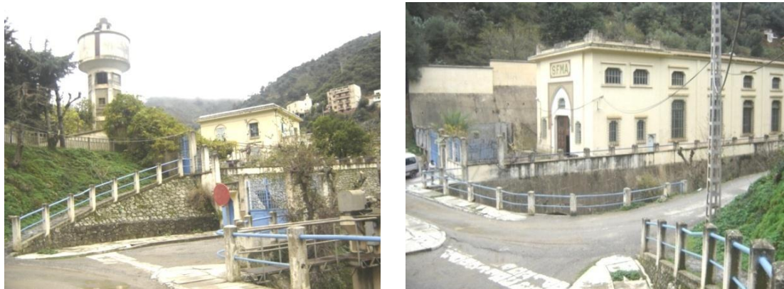
Fig. II.2. La centrale hydraulique de Boghni (Tizi-Ouzou) [23]
