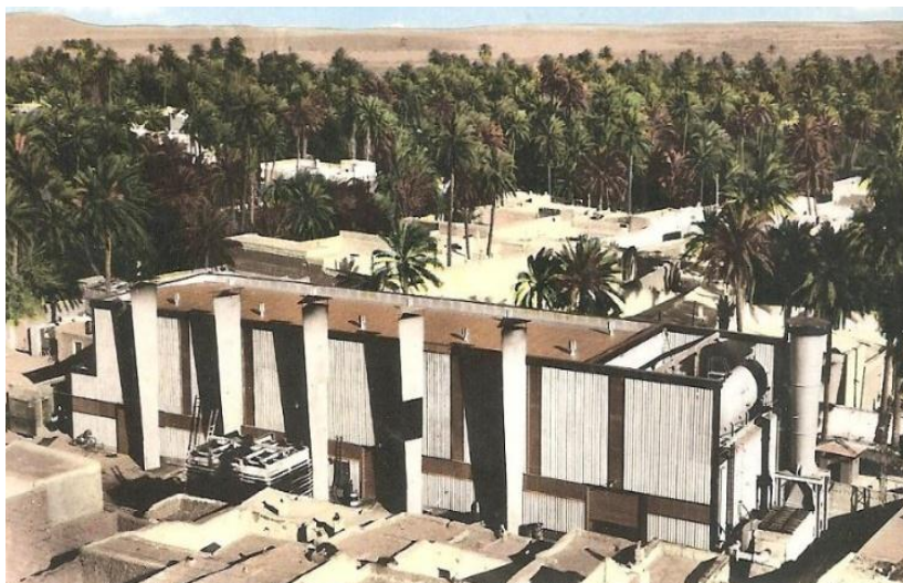
Fig. II.1 : La centrale électrique de Laghouat [22]
